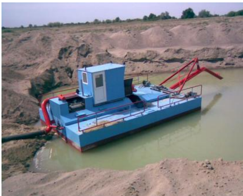
Рисунок 2.1 – Работающий в котловане земснаряд
