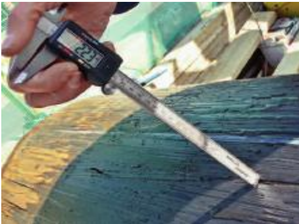
Рисунок №37 Замер глубины царапин в стенке трубы после протяжки
