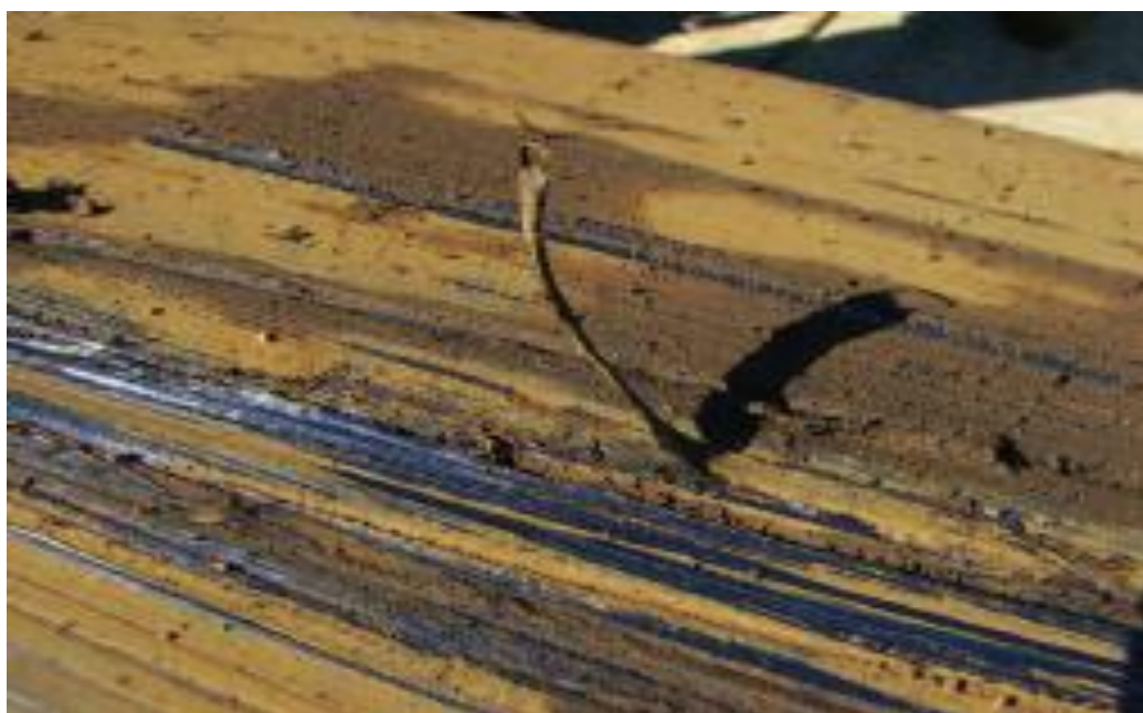
Рисунок №38 Выскабливание стенки трубы
