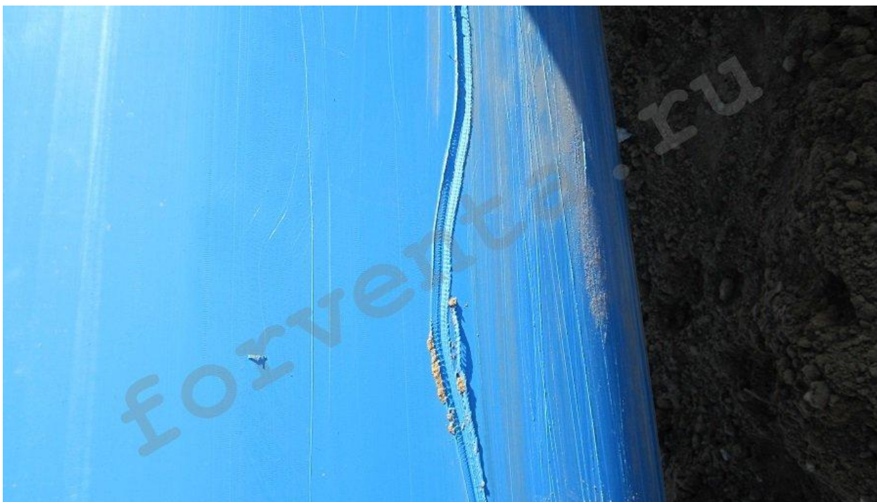
Рисунок №10 Защитная оболочка после протаскивания в старой трубе
