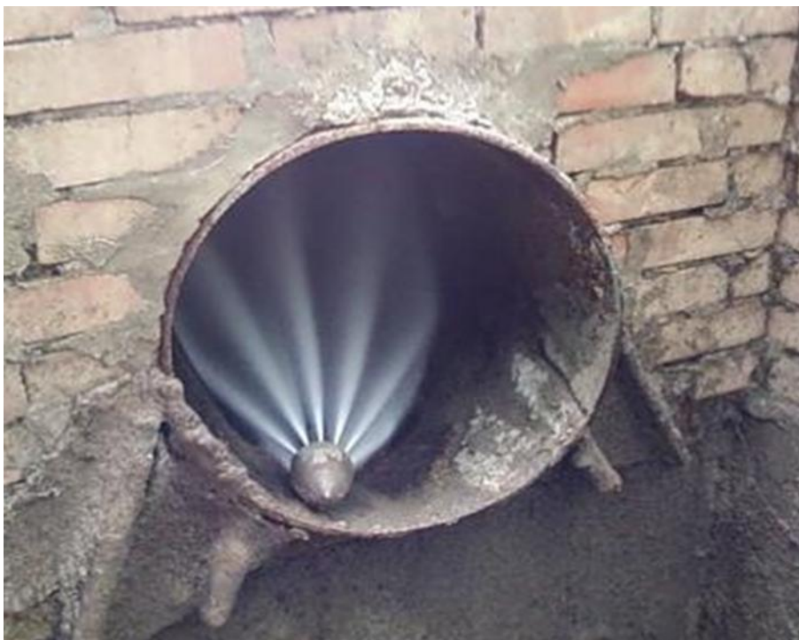
Рисунок №18 Прочистка гидравлическим способом
