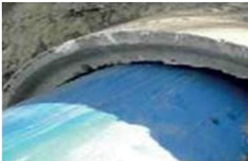
Рисунок №35 Протяжка трубы с защитным покрытием
