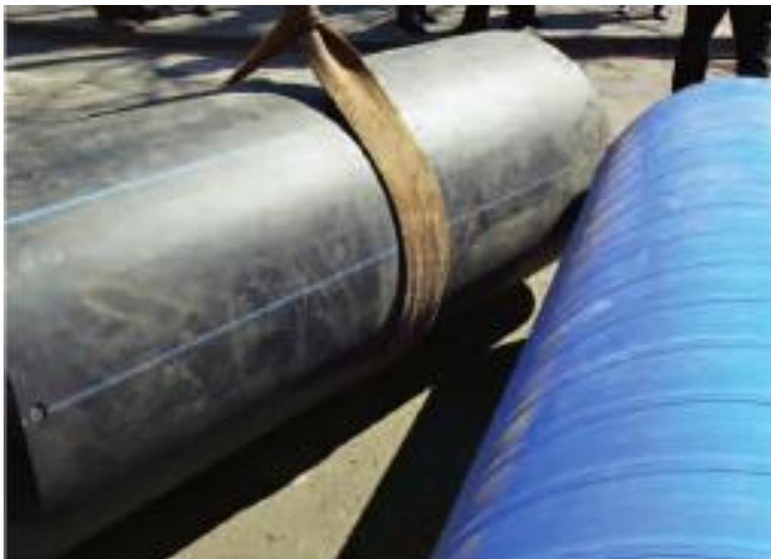
Рисунок №34 Отрезки труб для производственного испытания
