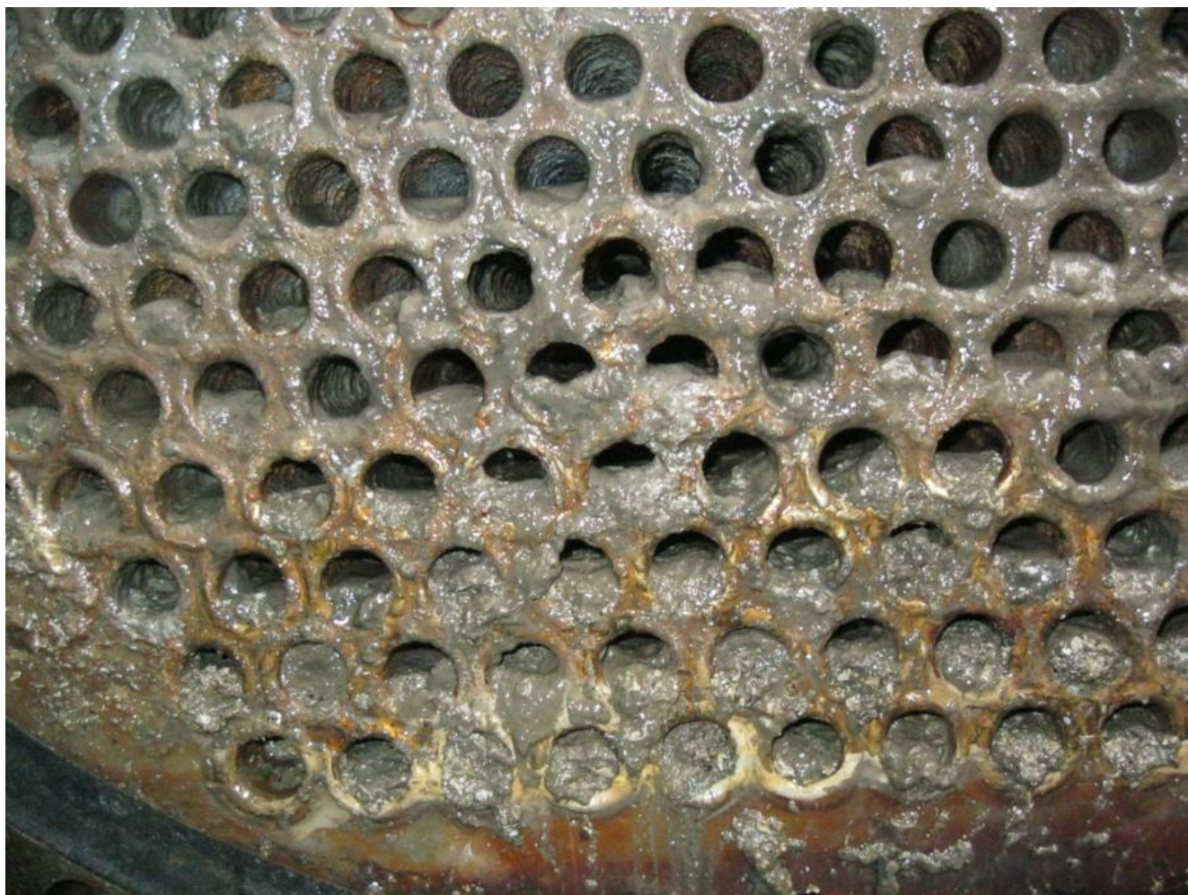
Рисунок 1.2 – Результат деятельности слизиобразующих бактерий в теплообменном оборудовании ОАО «Минудобрения» г. Россошь
