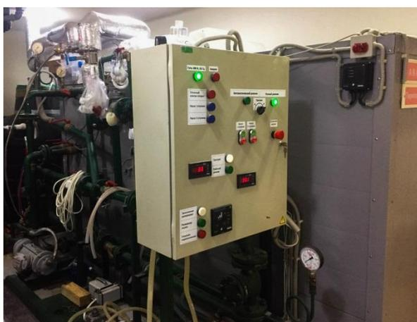
Рисунок 1 – Панель управления установки по обеззараживанию сточных вод ОСВ – 2,5
