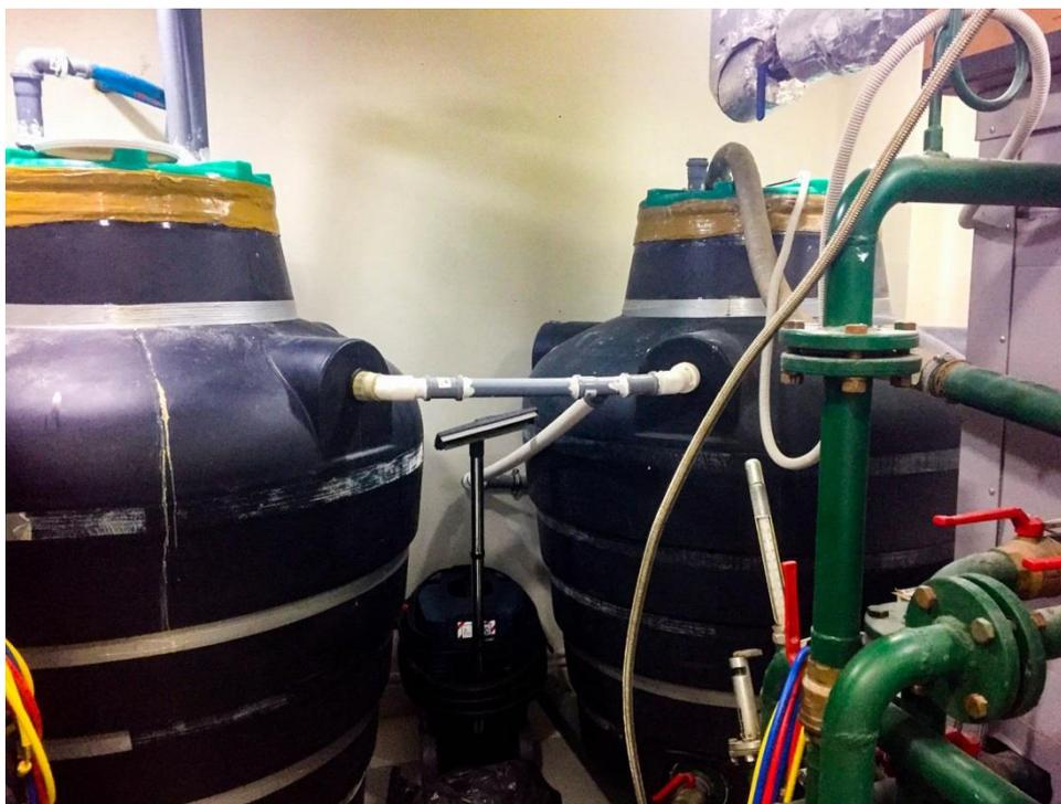
Рисунок 2 – Накопительные емкости установки по обеззараживанию сточных вод ОСВ–2,5
