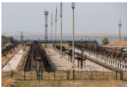
Рисунок 2.3 – Эстакада для слива мазута из цистерн
