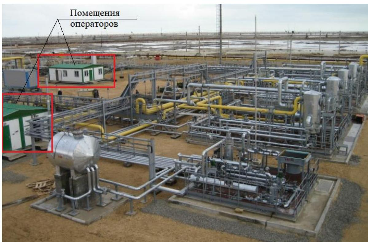
Рисунок 3 – Установка предварительной подготовки газа (УППГ)
