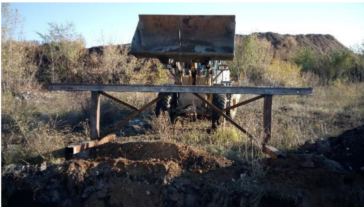
Рисунок В.19 – Транспортировка упорной фермы к месту проведения испытаний
