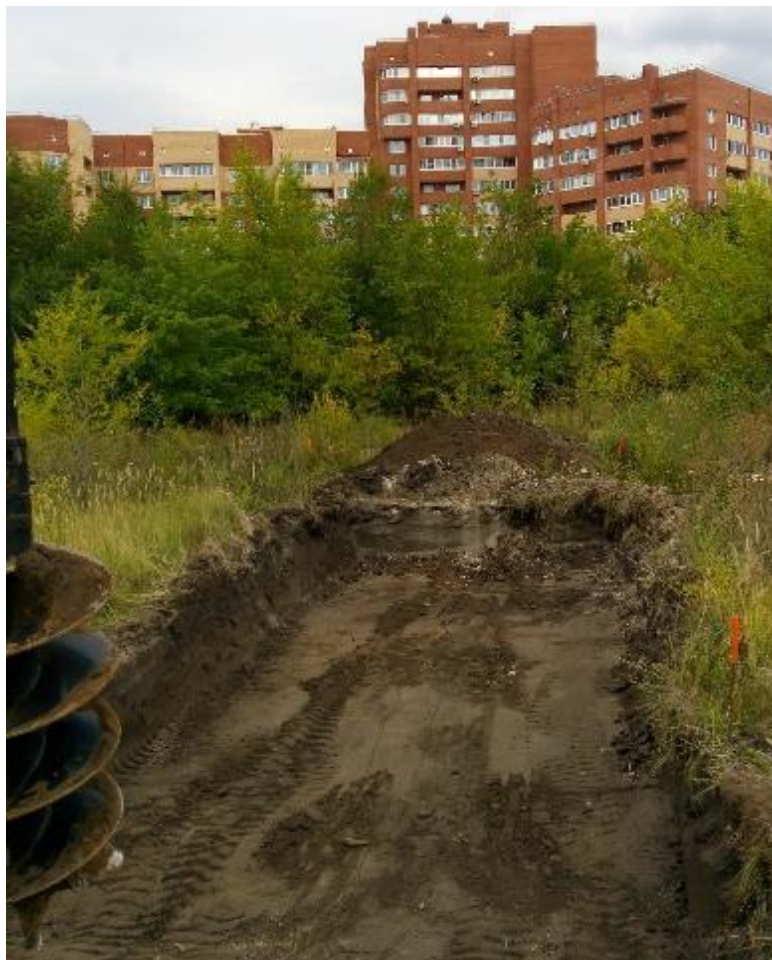
Рисунок В.6 – Подготовленный котлован для проведения эксперимента
