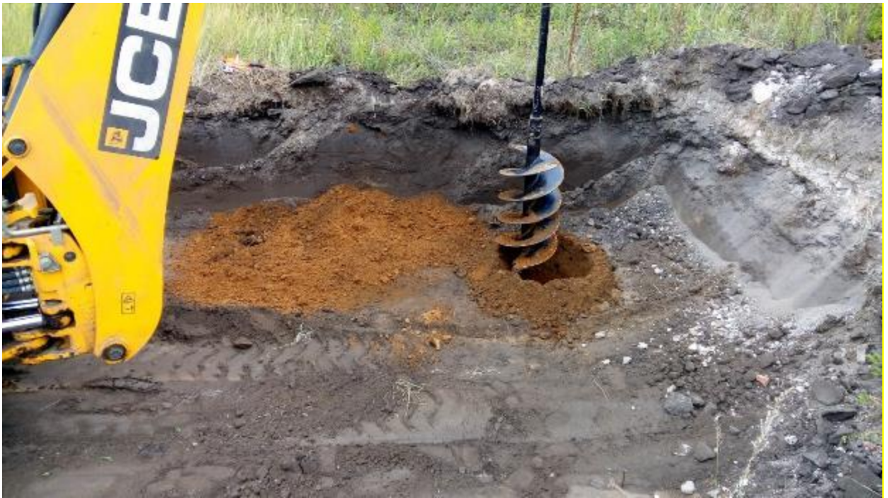
Рисунок В.7 – Бурение скважин анкерных свай экскаватор-погрузчиком JCB
