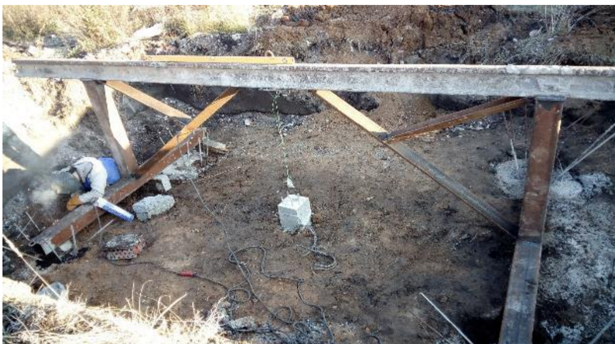
Рисунок В.20 – Монтаж и сварка упорной фермы к анкерным сваям
