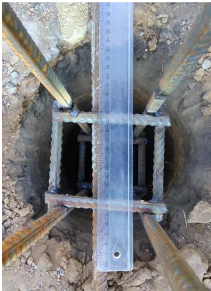
Рисунок В.15 –Проверка сечения испытываемой сваи
