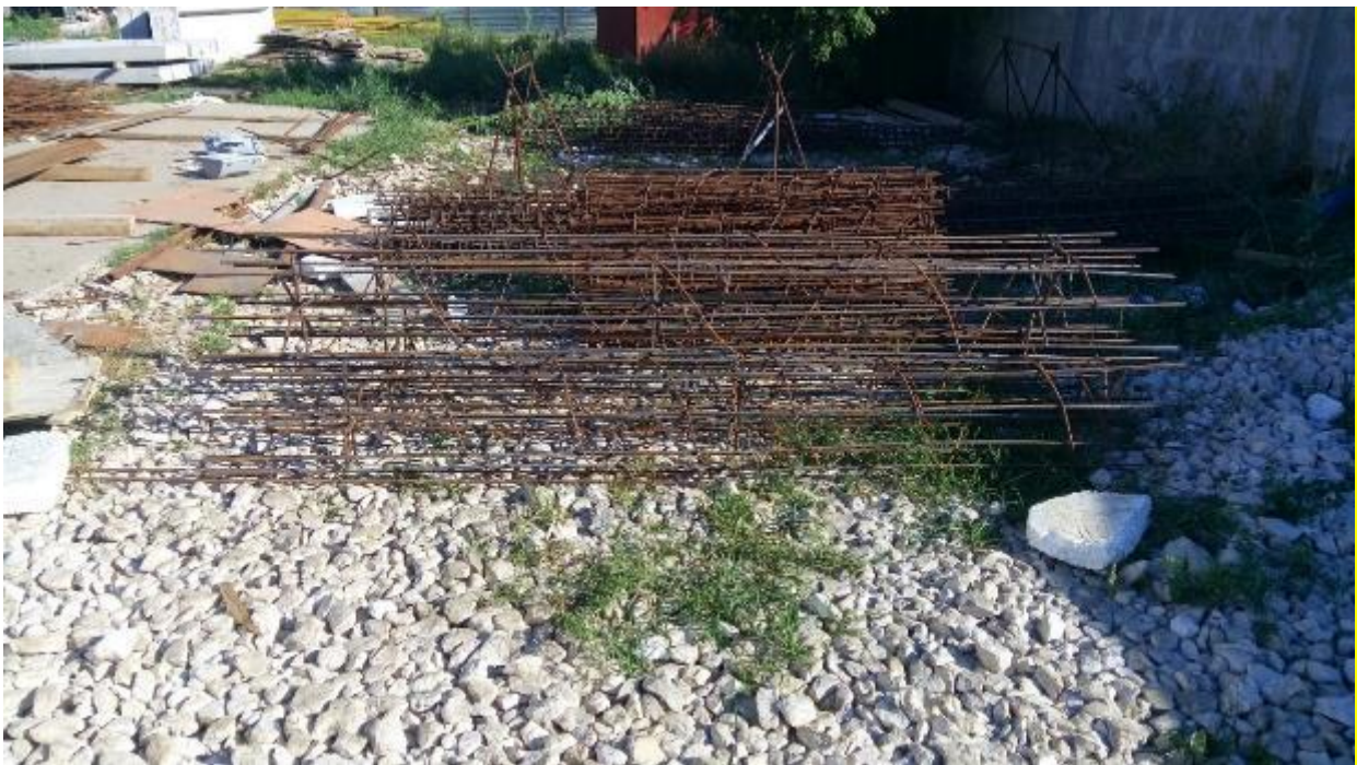
Рисунок В.2 – Каркасы анкерных свай
