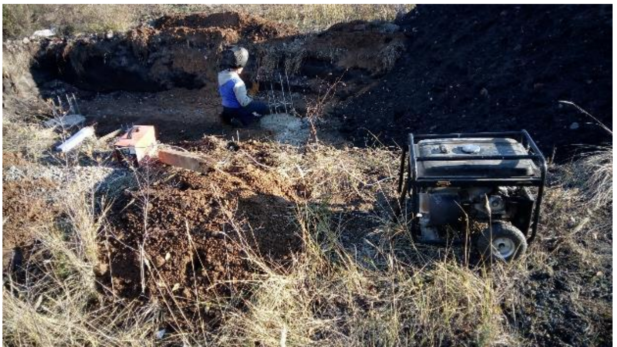
Рисунок В.18 – Подготовка генератора и сварочного аппарата для сварки упорной фермы к анкерным сваям
