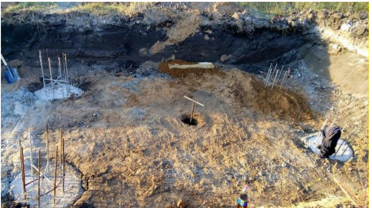
Рисунок В.12 – Бурение скважины испытуемой сваи ручным буром
