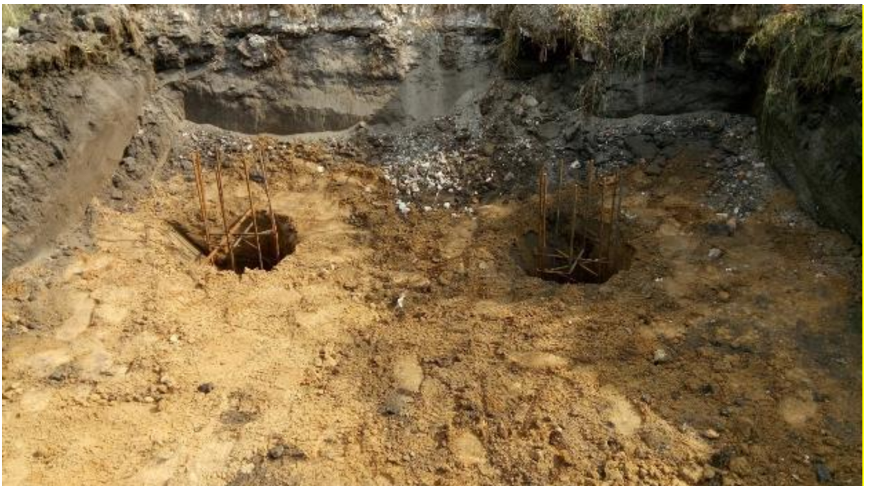
Рисунок В.10 – Армирование анкерных свай
