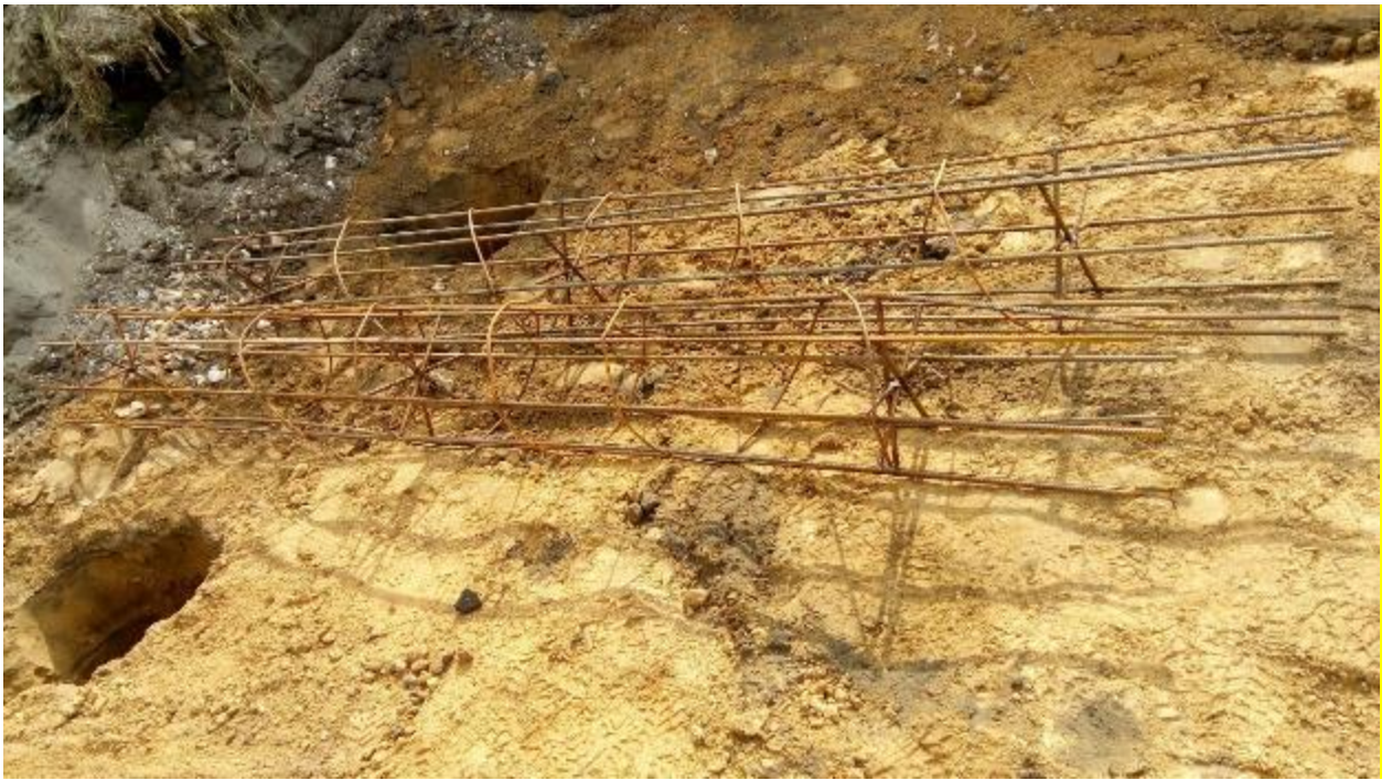
Рисунок В.9 –Общий вид скважин и каркасов анкерных свай
