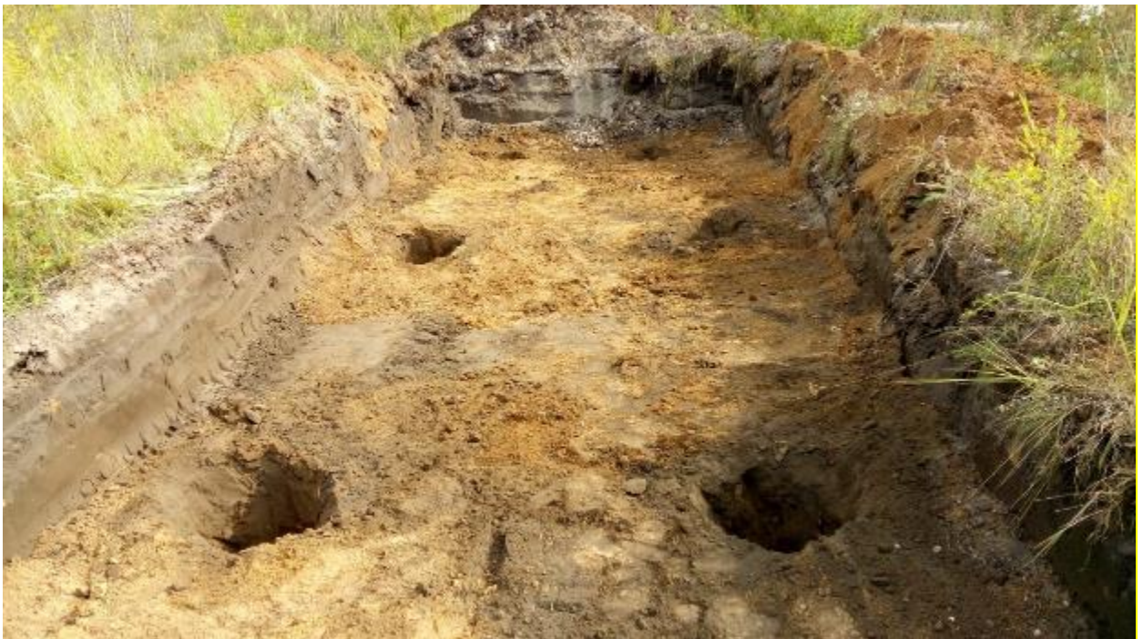
Рисунок В.8 – Готовые скважины анкерных свай
