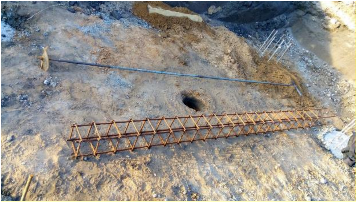
Рисунок В.13 – Общий вид скважины и каркаса испытываемой сваи
