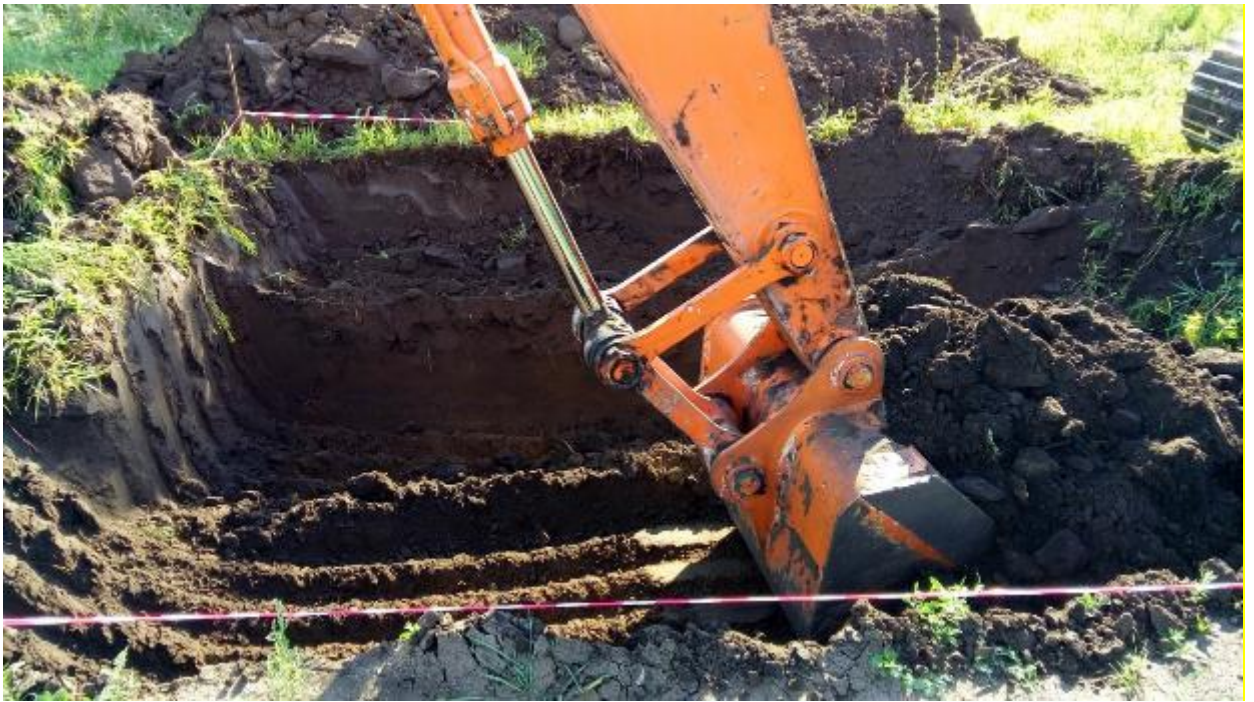
Рисунок В.5 - Срез почвенно-растительного слоя экскаватором Hitachi
