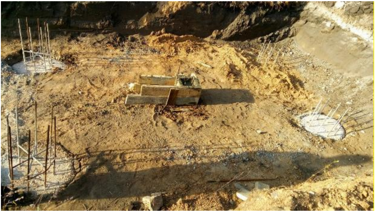
Рисунок В.17 – Общий вид анкерных и испытываемой свай
