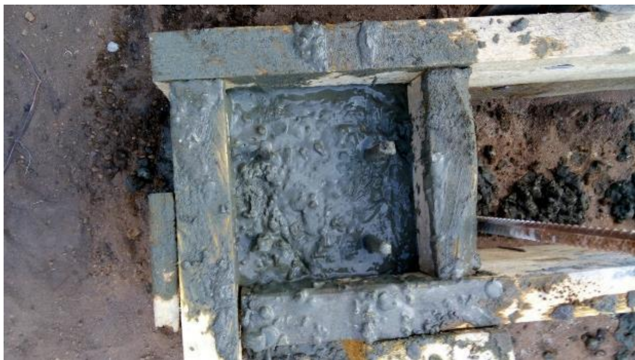
Рисунок В.16 – Бетонирование испытываемой сваи
