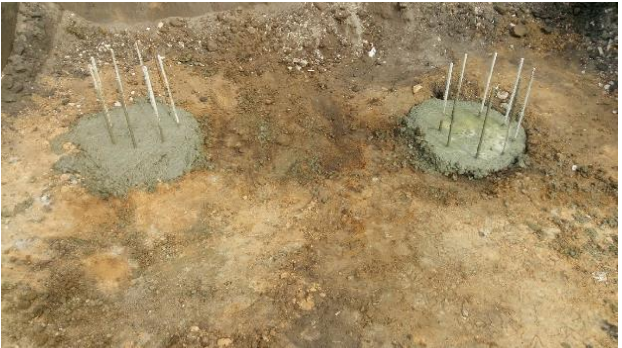
Рисунок В.11 – Бетонирование анкерных свай
