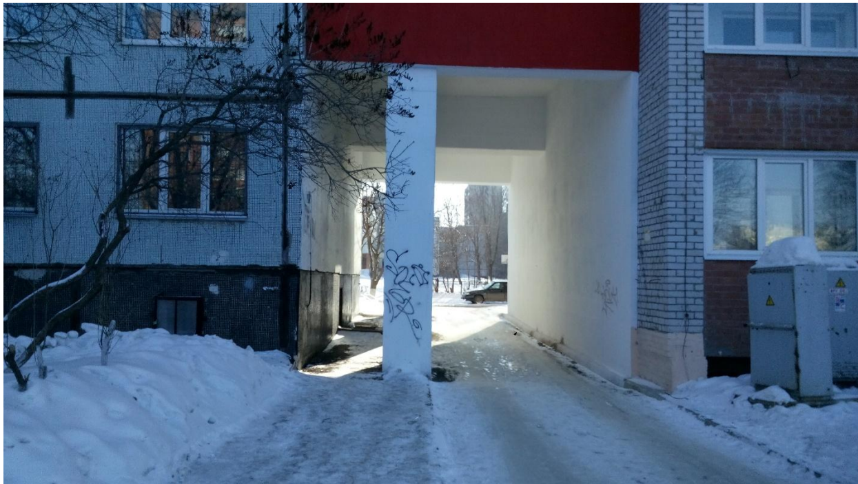
Рисунок 17 - Сквозной проезд под торцевыми секциями дома-вставки
