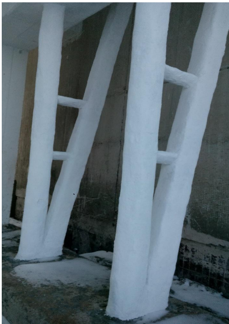
Рисунок 19 - Ж/б стойки усиления под поперечными балками дома-вставки
