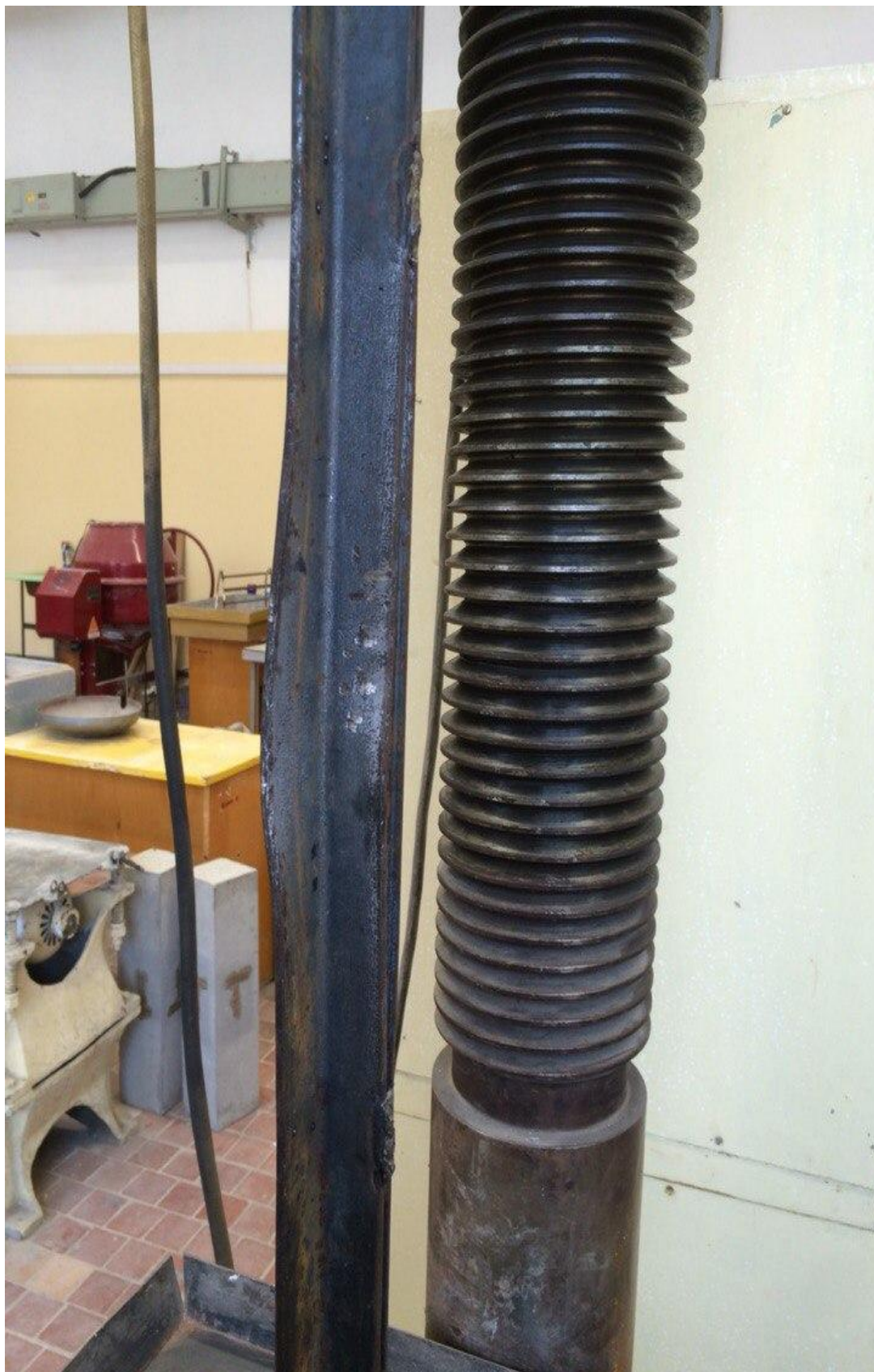
Рисунок Б.1 - Вид деформированного стержня до испытания
