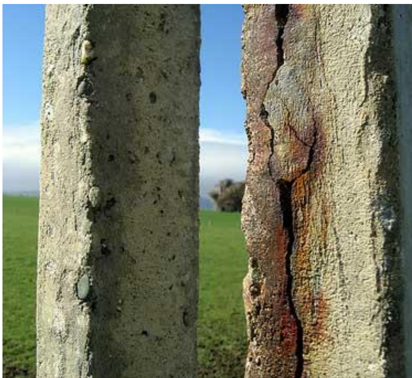
Рисунок 11 – Конструкция с промасливанием верхних слоев бетона
