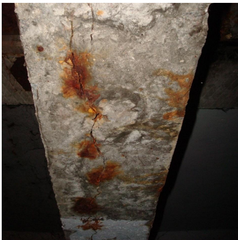
Рисунок 12 – Коррозия арматуры
