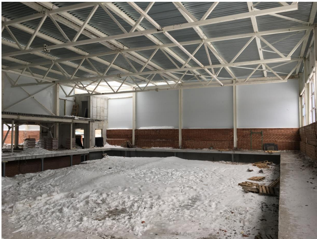
Рисунок Б.6 – Фото строящегося объекта, зона чаши бассейна (зима)
