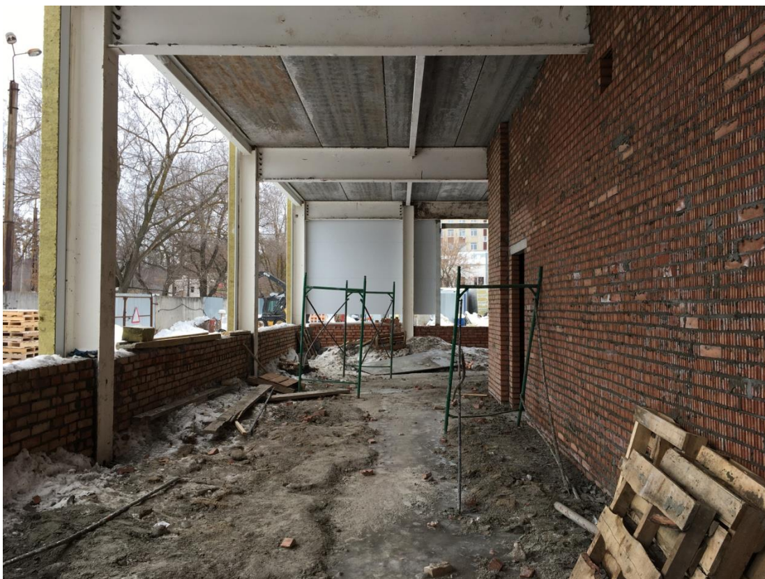
Рисунок Б.7 – Фото строящегося объекта, зона ресепшен (зима)
