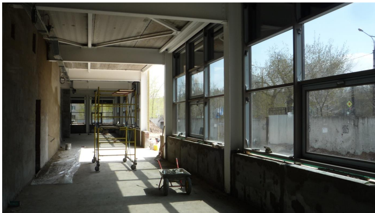
Рисунок Б.8 – Фото строящегося объекта, зона холла (весна)
