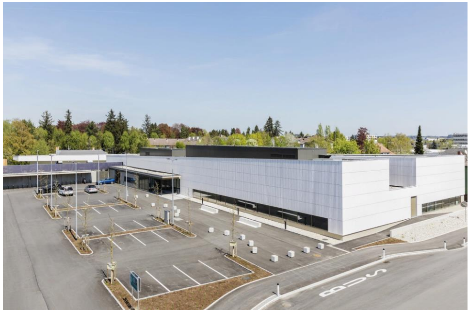
Рисунок В.1 – Здание RIED IM INNKREIS
