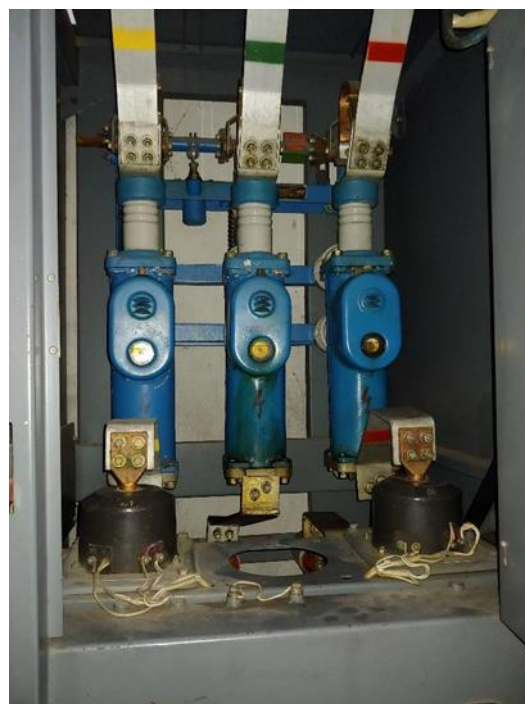
Рисунок 2 – Ячейка КСО-272 Рисунок 3– Выключатель масляный ВМГ-10
