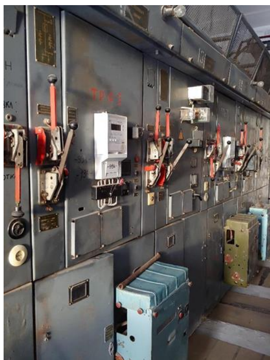
Рисунок 2 – Ячейка КСО-272 Рисунок 3– Выключатель масляный ВМГ-10
