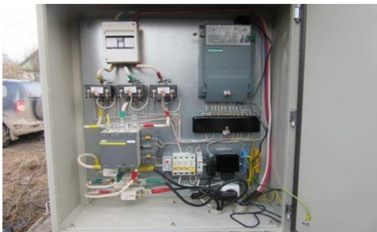
Рисунок 8 – Щит простейший автоматического освещения
