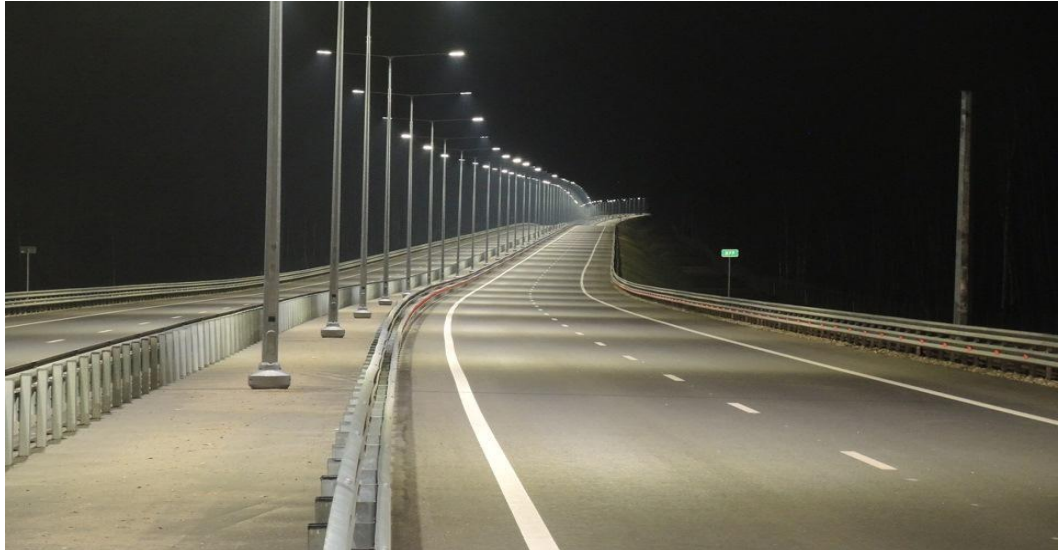
Рисунок 3 – Центральное освещение дороги
