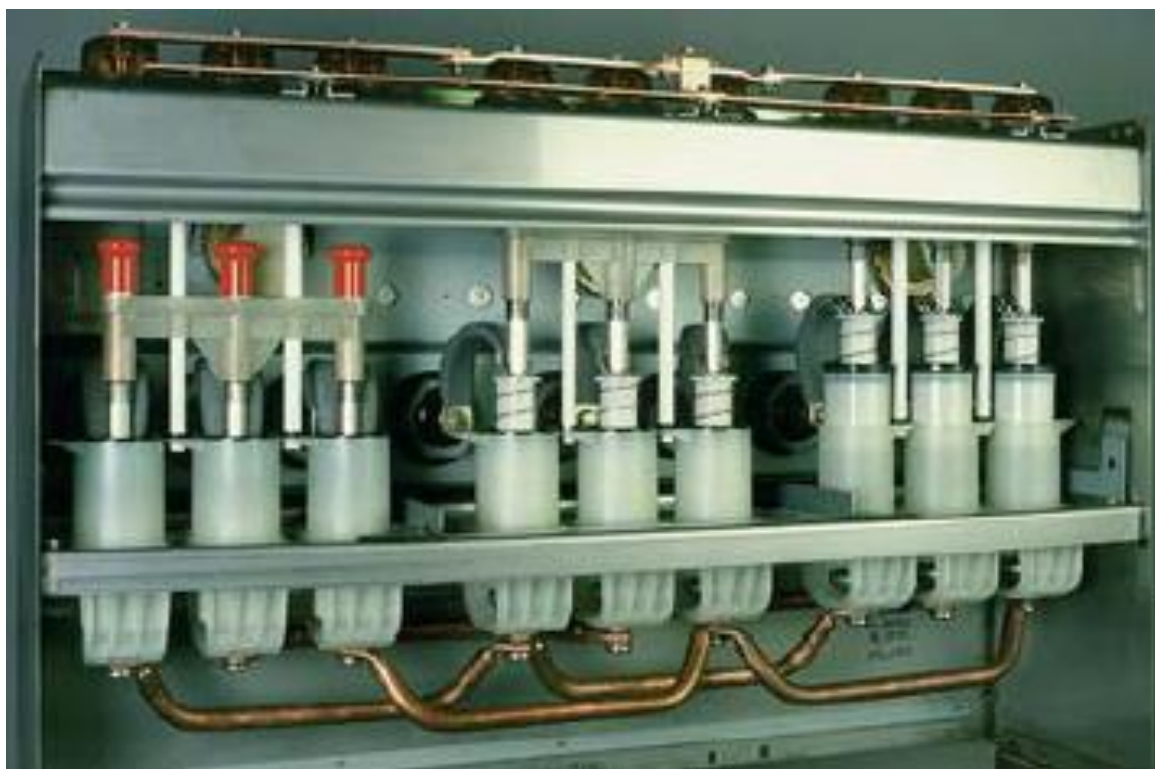
Рисунок 4.2 – Коммутационные аппараты, применяемые в RM-6 NE-IIID.
