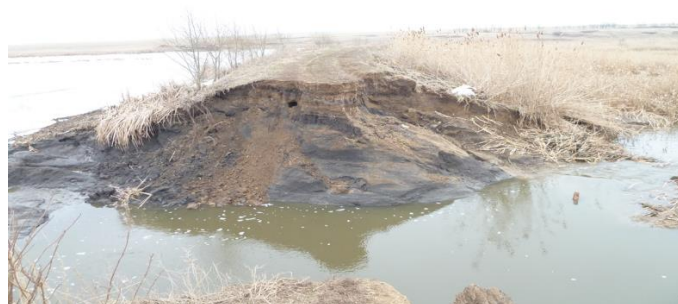
Рисунок 5 – Проран на пруду руслового «Зазерский»
