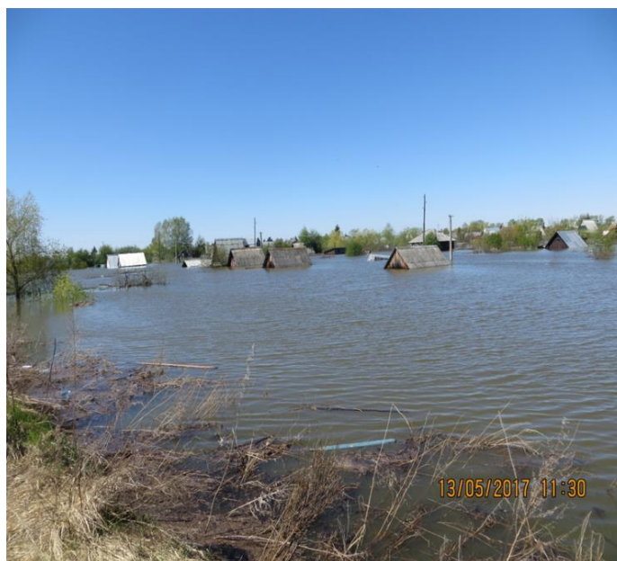
Рисунок 8– Подтопленные садоводческие участки
