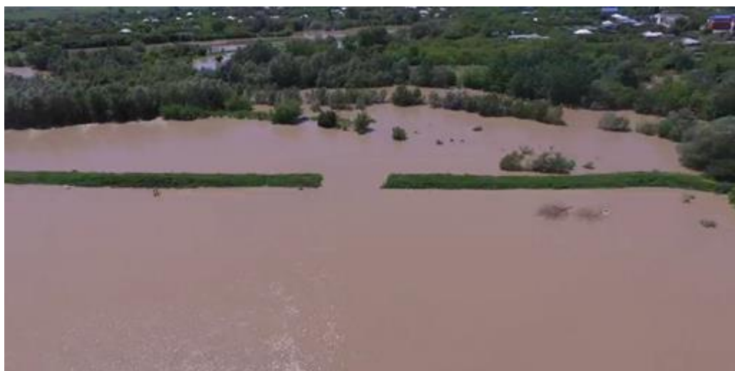
Рисунок 6 - Проран в дамбе на реке Фарс
