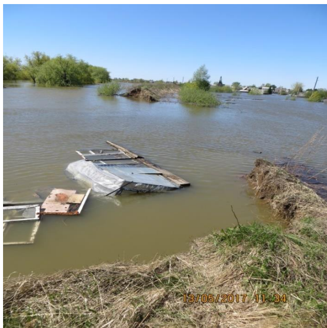
Рисунок 7 - Проран противопаводковой дамбы на реке Ишим
