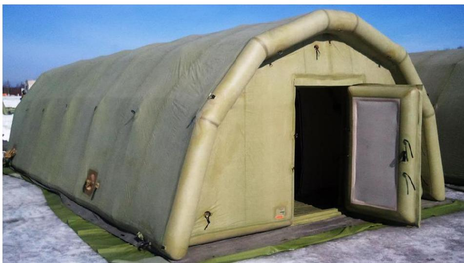
Рисунок 1 - Пневмокаркасная конструкция для полевого госпиталя
