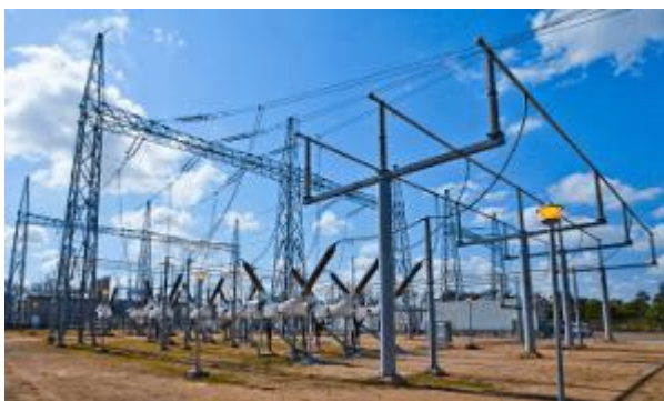
Рисунок 27- ОРУ на 35 кВ
