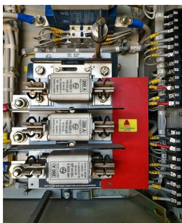
Рисунок 44- Предохранители HRC
