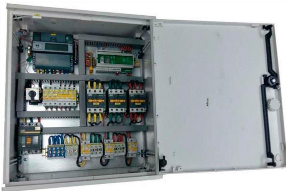
Рисунок 21 – Шкаф управления наружным освещением (ШУНО) «Unilight»
