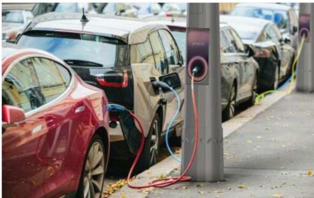
Рисунок 9 – Интеллектуальный уличный светильник с зарядным устройством для электромобилей
