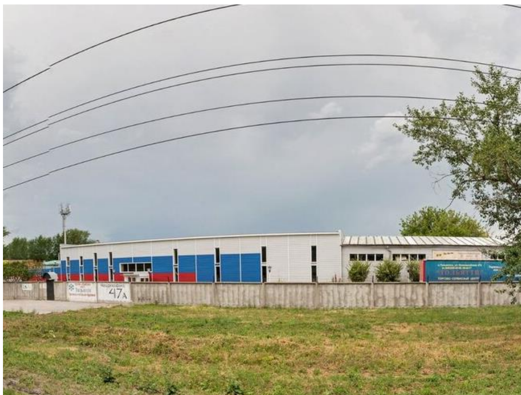
Рисунок 1 – Вид фасада основного корпуса ТСЦ «Тольятти»
