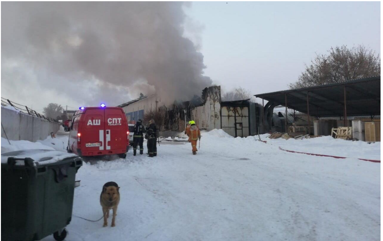
Рисунок 2 – Вид складского помещения ТСЦ «Тольятти» после тушения пожара
