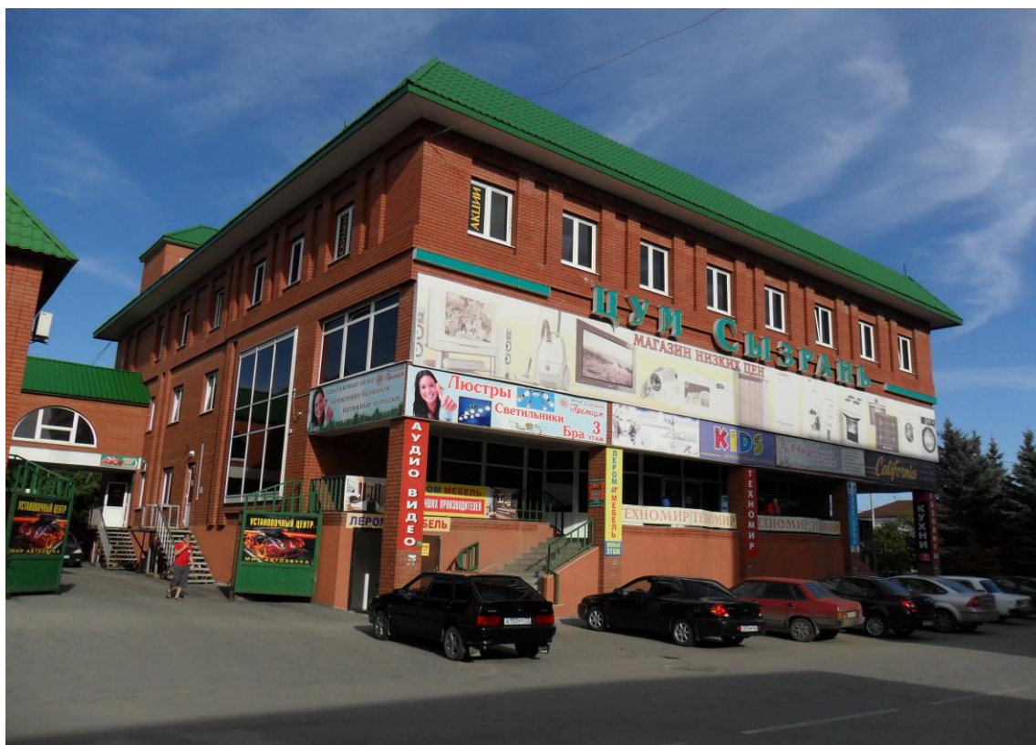
Рисунок 1 – Внешний вид здания торгового центра
