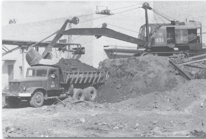
Рис. 3.6. Строительство Волжского автозавода (1969 г.) Уборка излишков грунта на одном из участков стройплощадки после прокладки здесь подземных коммуникаций.
