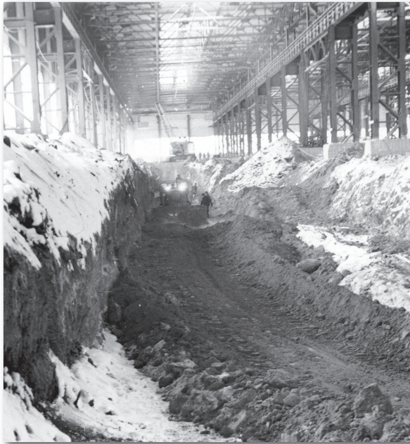
Рис. 4.7, а. Строительство Волжского автозавода. Цех алюминиевого литья (январь 1969 г.)
