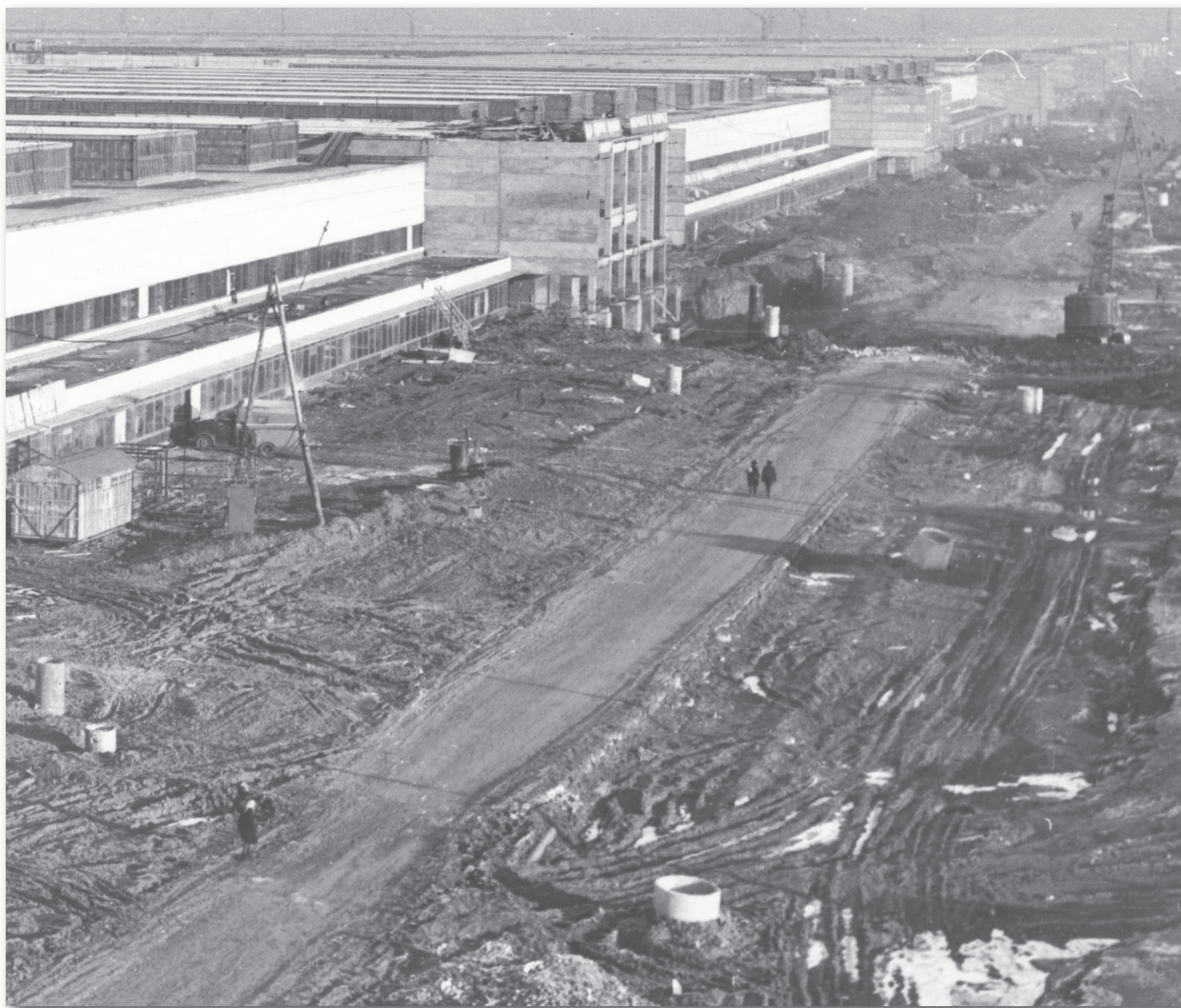
Рис. 2.3. Строительство Волжского автозавода (ноябрь 1969 г.)
