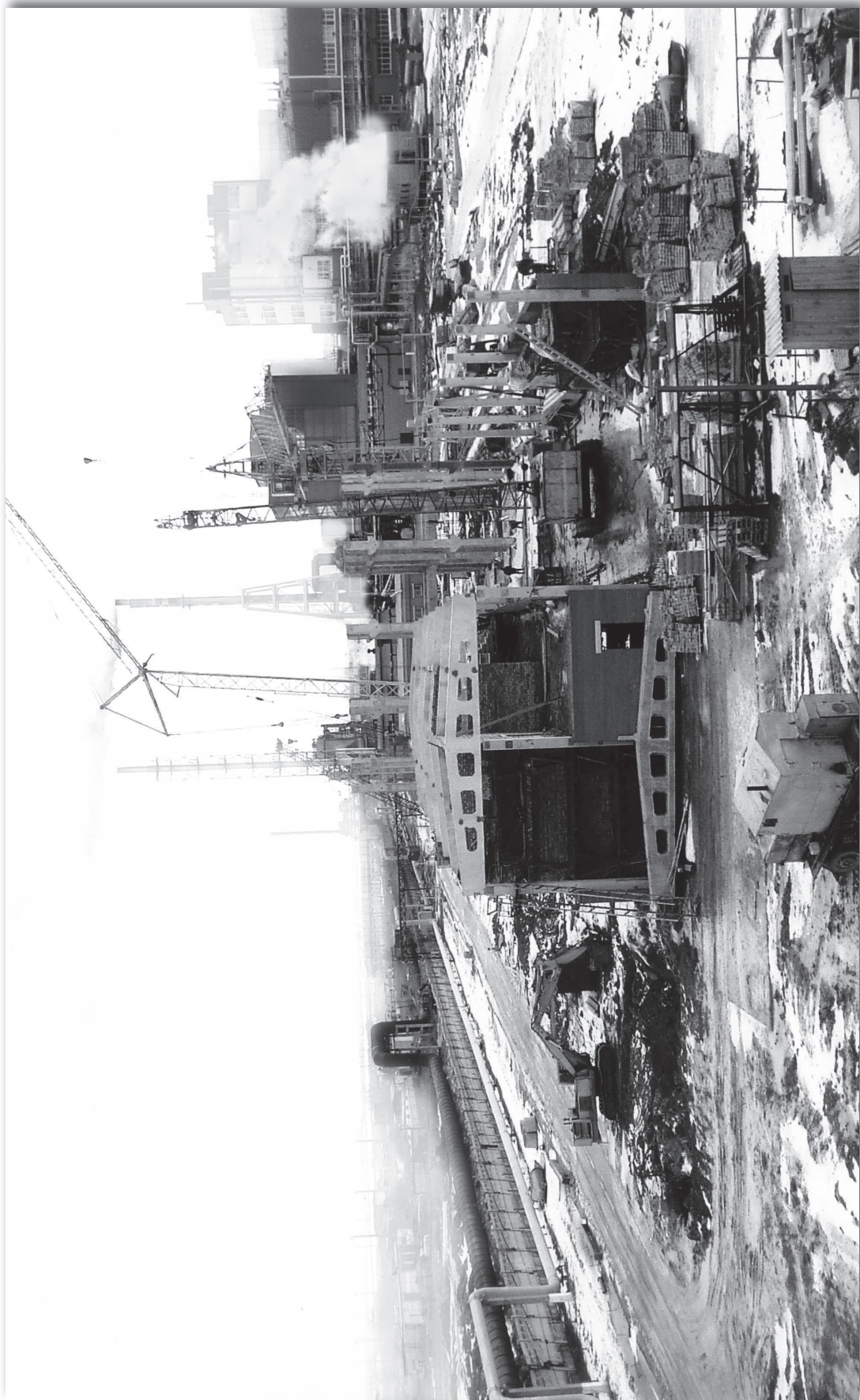
Рис. 4.8,г. Площадка полимида-6 (по рис. 4.8, а, в) в ноябре 2006 г. Работы продолжаются в нормальных условиях. Гусеничный кран г/п 25 т перешёл на готовый участок чёрного пола. Экскаватор сантехников приступил к работам в понижении « дефиле» вдоль дороги I—I (слева). На заднем плане ведётся монтаж колонн каркаса. Начат подъём башенного крана (БК).
