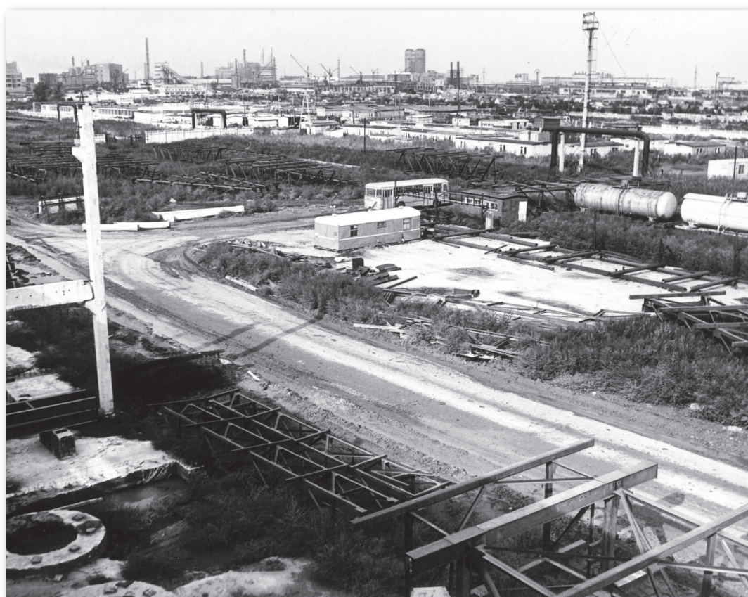
Рис. 4.5. Участок стройплощадки производства капролактама-2 с элементами системы ОПД (ПО «Куйбышевазот», 1986 г.)
