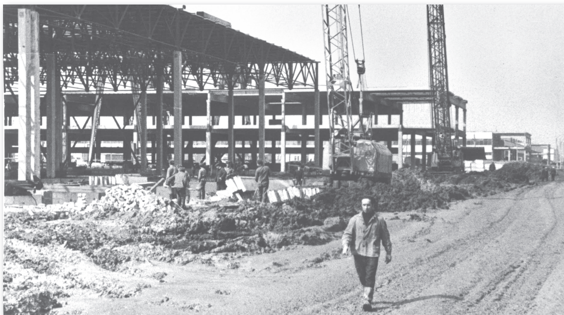
Рис. 1.2. Строительство Волжского автозавода (май 1969 г.)
