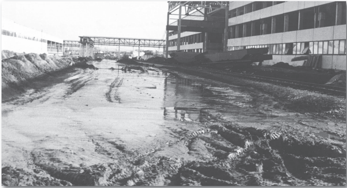
Рис. 2.1. Строительство Тольяттинского азотного завода (апрель 1977 г.)
