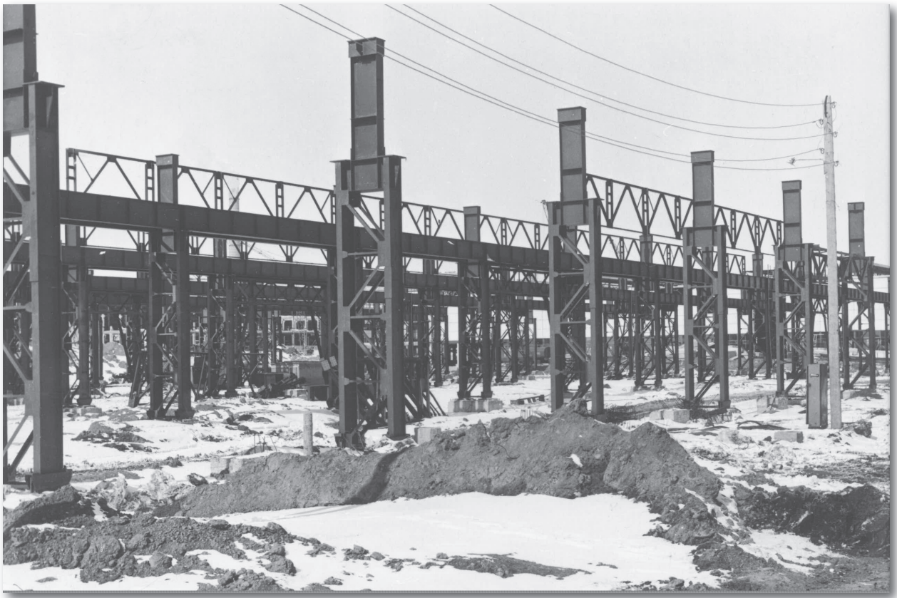
Рис. 2.4. Строительство Волжского автозавода (март 1969 г.)
