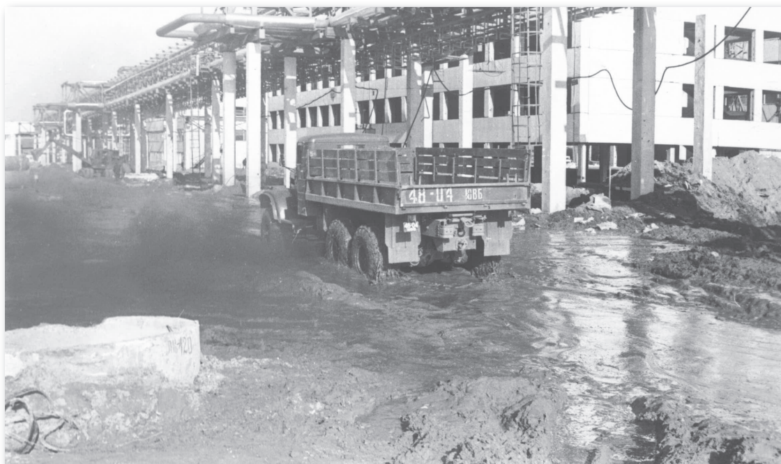
Рис. 1.1. Строительство Тольяттинского азотного завода (апрель 1977 г.)
