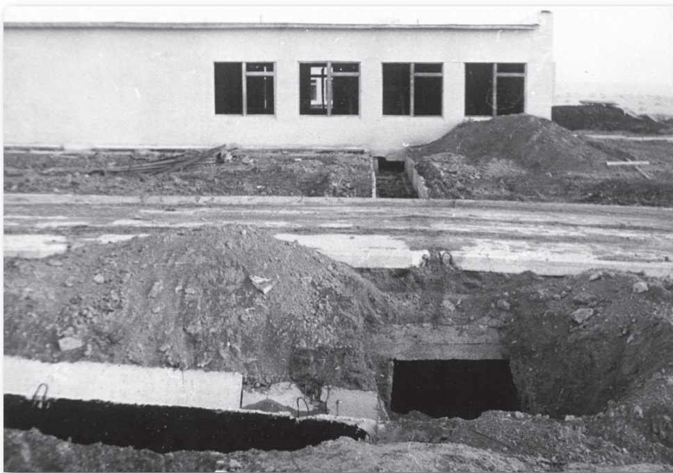
Рис. 4.3. Участок действующей дороги ОД с опережающим пересечением (лотком) под ней на строительстве компрессорной станции КС-2 газопровода Оренбург – Самара (1974 г.)
