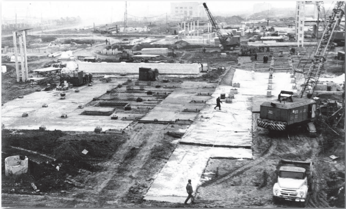
Рис. 4.2. Общий вид стройплощадки производства аммиака А-410 на Куйбышевском азотно-туковом заводе (сентябрь 1975 г.)
