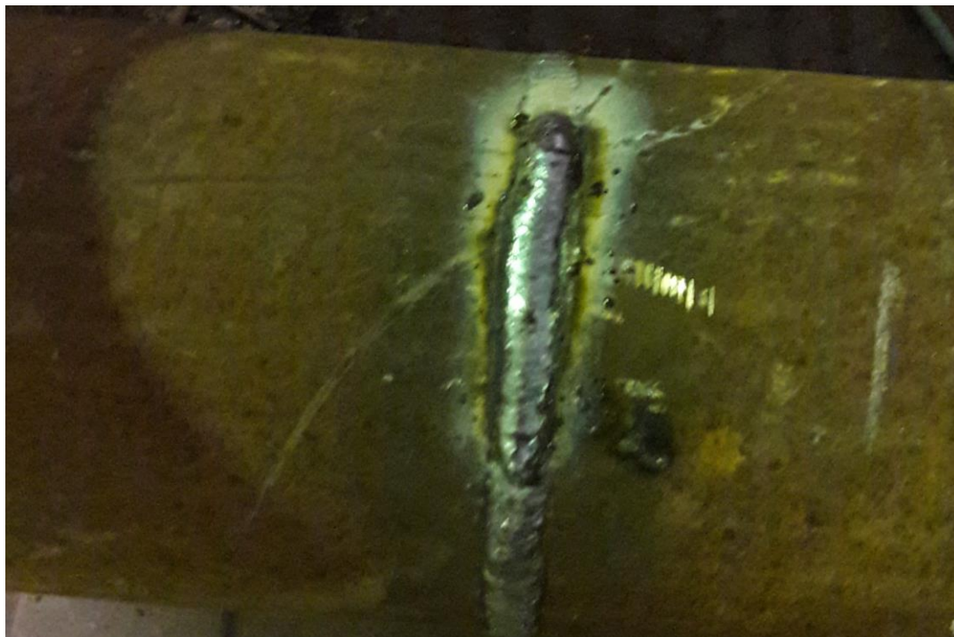
Рисунок 4.16 - Отремонтированный участок сварного соединения
