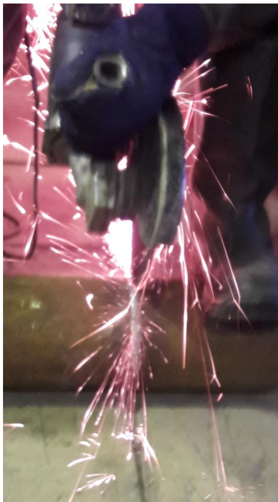
Рисунок 4.13 - Механическое удаление дефекта при помощи УШМ
