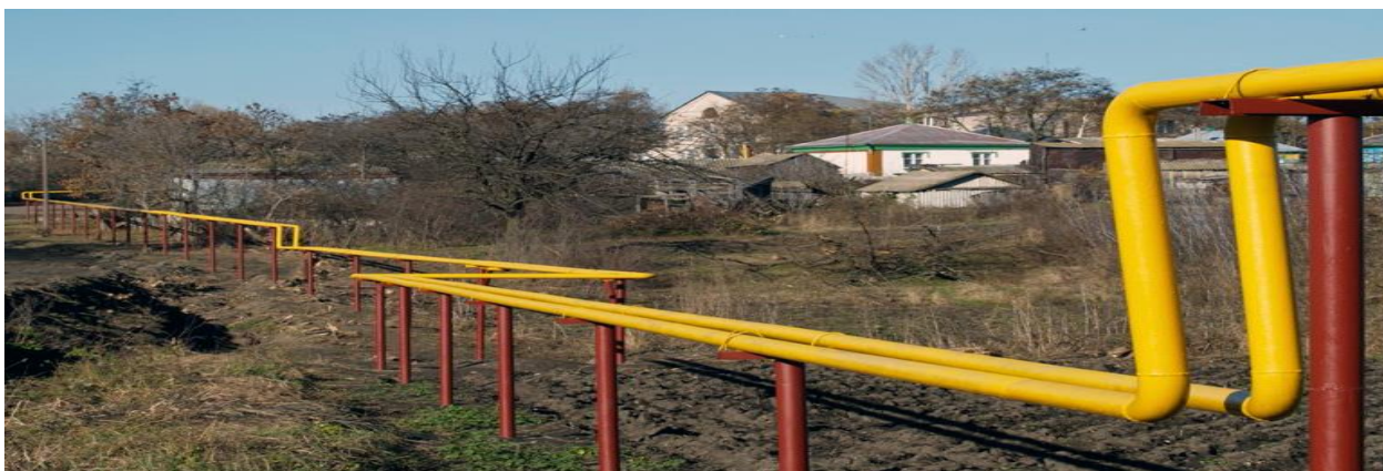
Рисунок 1.1 - Внешний вид фрагмента наружного надземного газопровода
