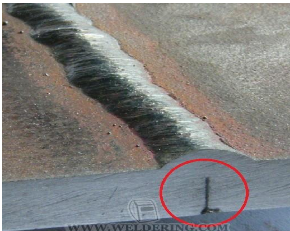
Рисунок 7 – несплавление в сварном шве.
