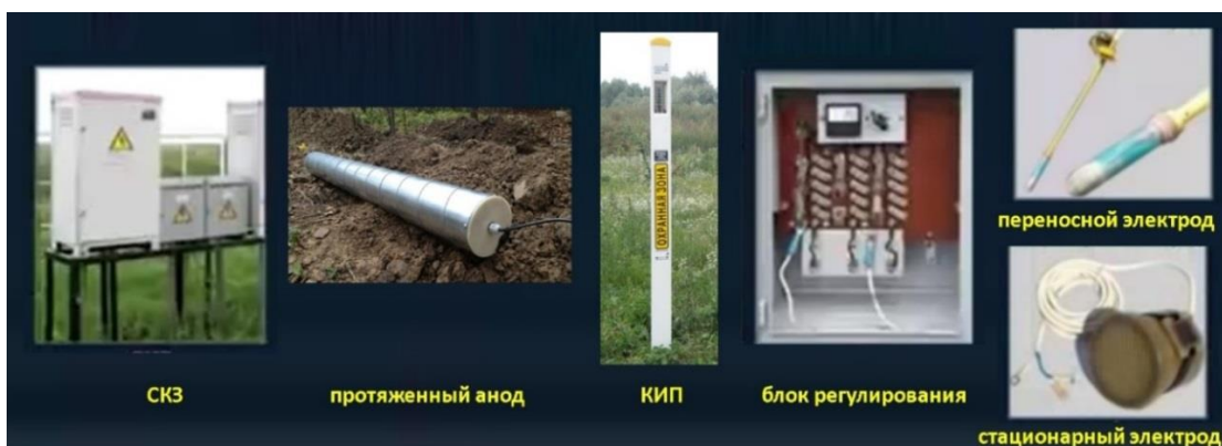
Рисунок 10 – Основные элементы установки катодной защиты
