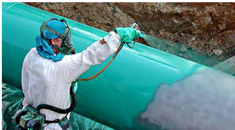
Рисунок 5 – Нанесение защитной краски на наружную поверхность надземного МГ
