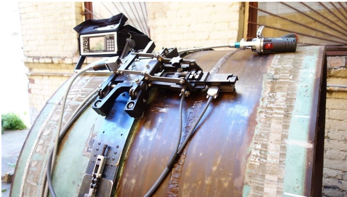
Рисунок 4.2 - Общий вид размещения ручного ультразвукового дефектоскопа Olympus CHAIN на проверяемом сварном шве изделия
