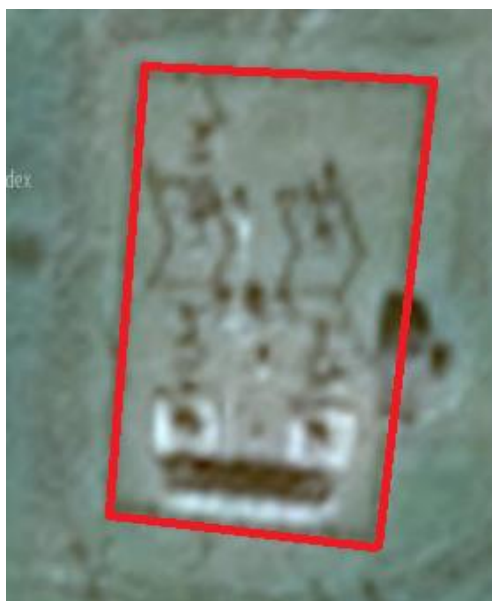
Рисунок 1.1 – Вид подстанции сверху
