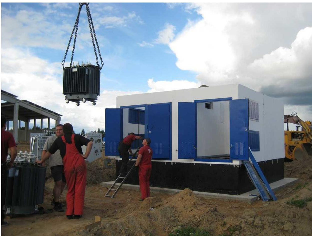
Рисунок 9 – Монтаж КТП
