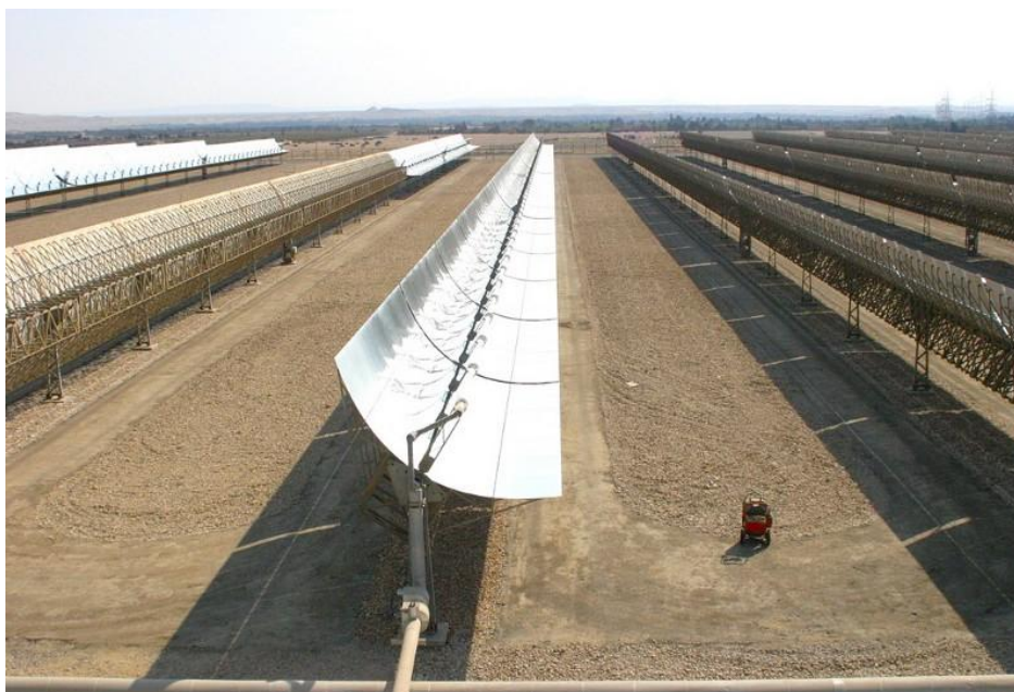
Рисунок 1.2 - СЭС, использующая параболические концентраторы
