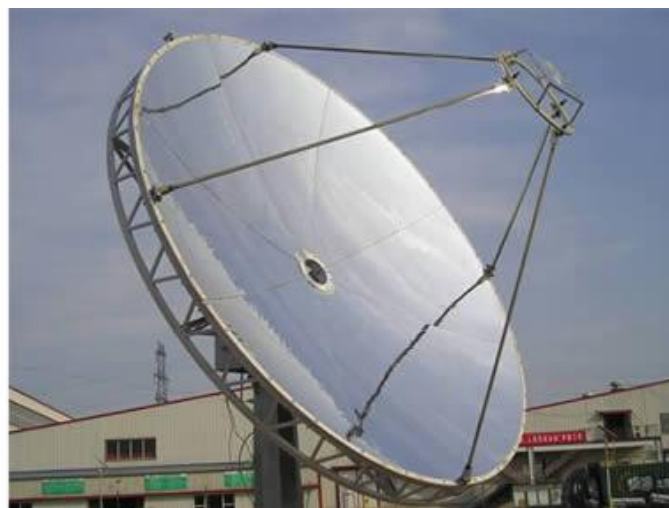
Рисунок 1.3 - Солнечная установка тарельчатого типа
