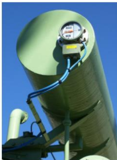
Рисунок 12- Указатель уровня масла MESSKO MTO-ST160(G)
