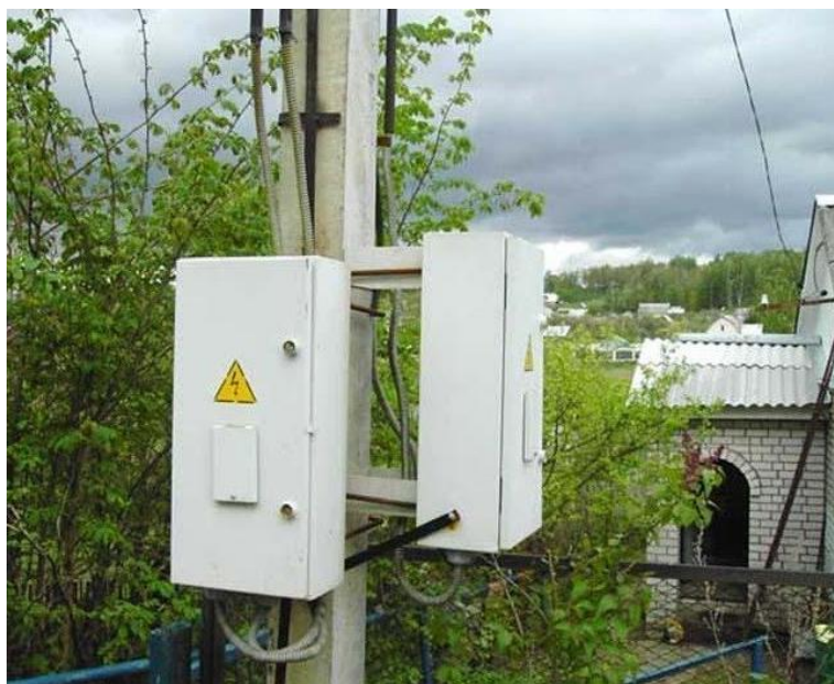
Рисунок 2.13 – Установка ВРУ дома
