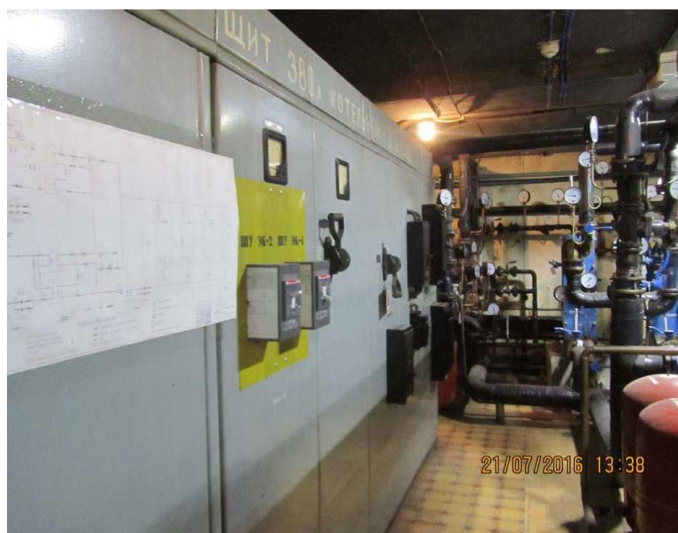
Рисунок 3 – Внешний вид секций РУ-0,4кВ КСК ЖГЭС
