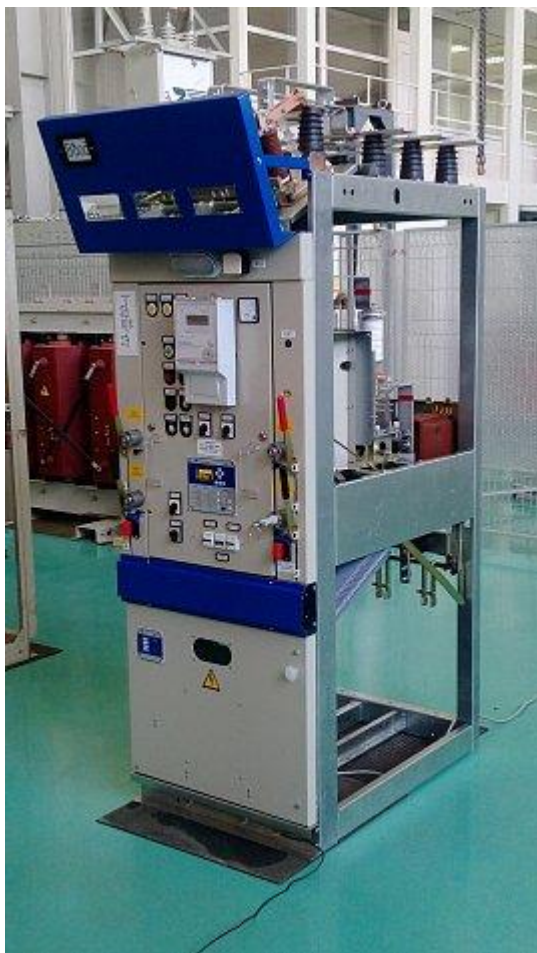
Рисунок 8.1 - Внешний вид камеры типа КСО-298М-1000
