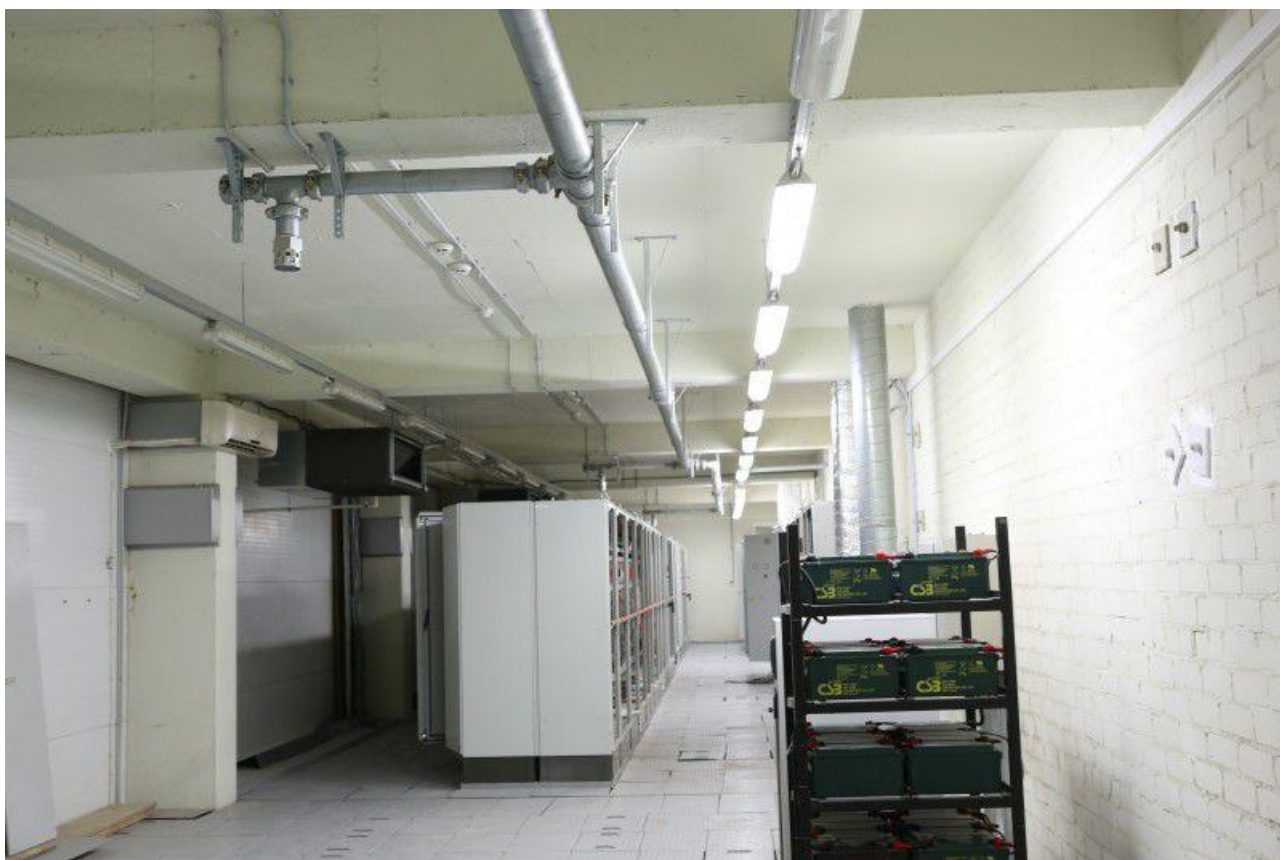
Рисунок 3.2 – Газовый трубопровод в аккумуляторной, применение газа для ликвидации возгорания на электроподстанции
