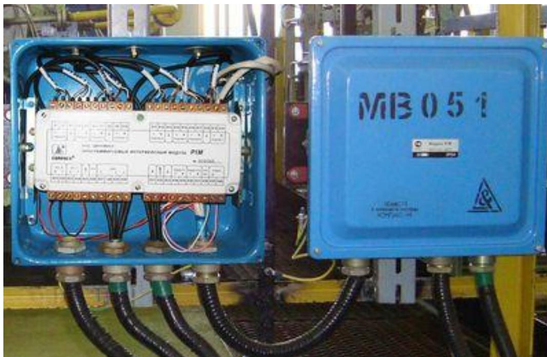
Рисунок 9 — Размещение программного интерфейсного модуля в защитной коробке
