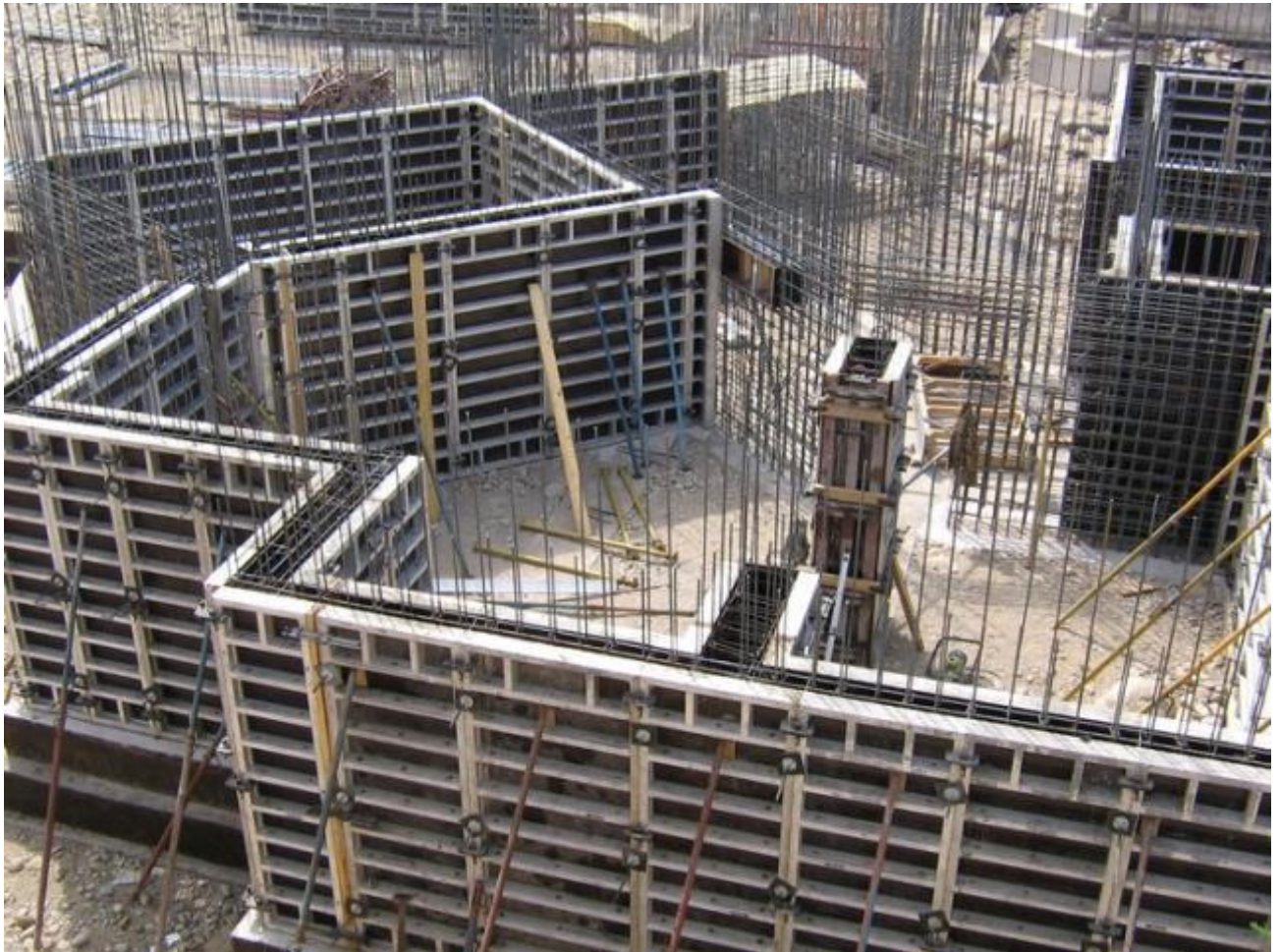
Рисунок 3 – Установка опалубки для ленточного фундамента
