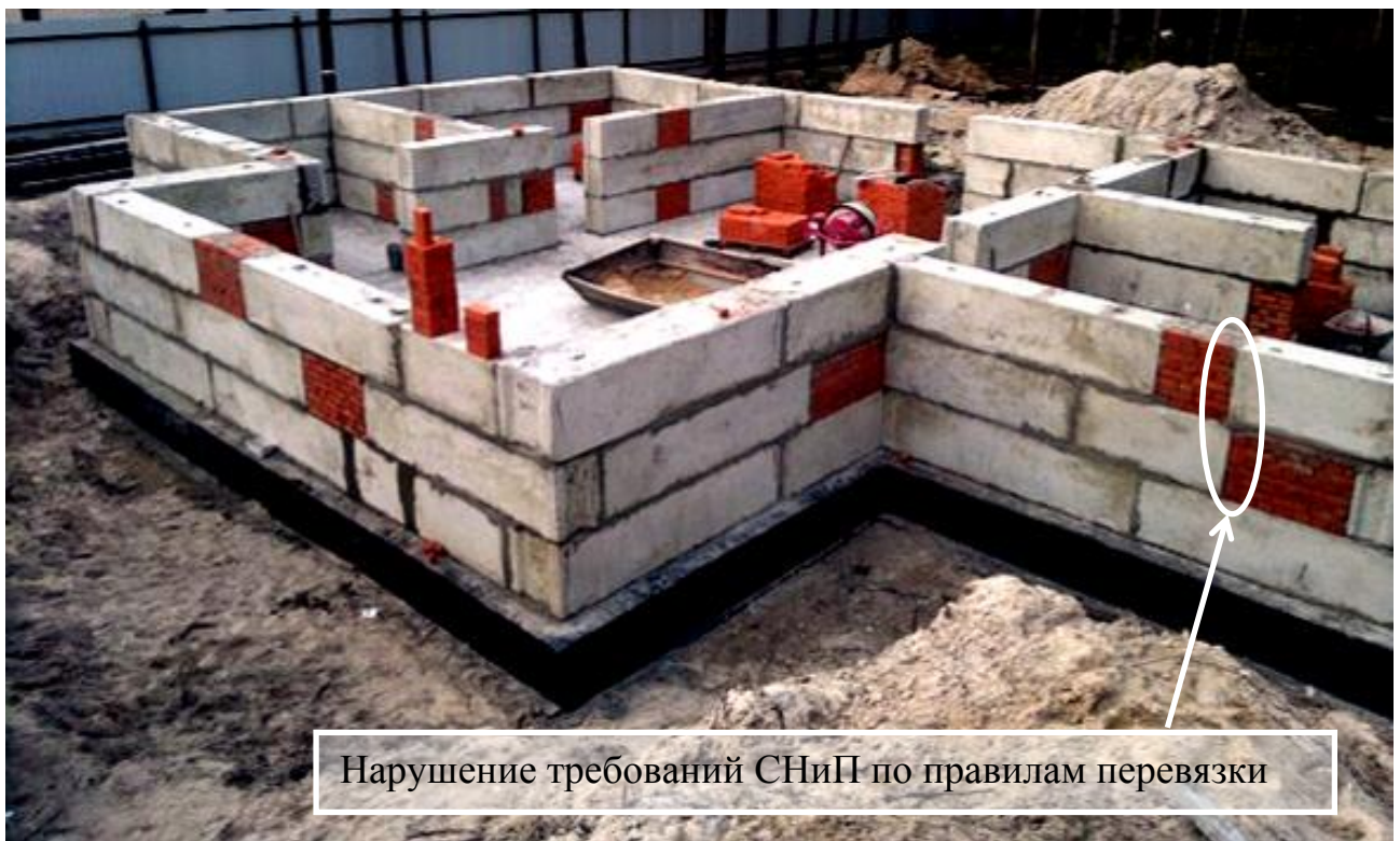
Рисунок 1 – Сборно-ленточный фундамент.
