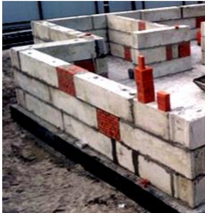
Рисунок 14 – закрытие промежутков между блоками с помощью ручной кладки кирпича
