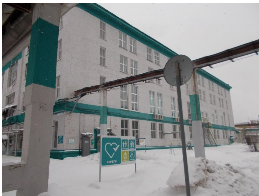
Рисунок 1.1 – Вид здания Е-2 с западной стороны.
