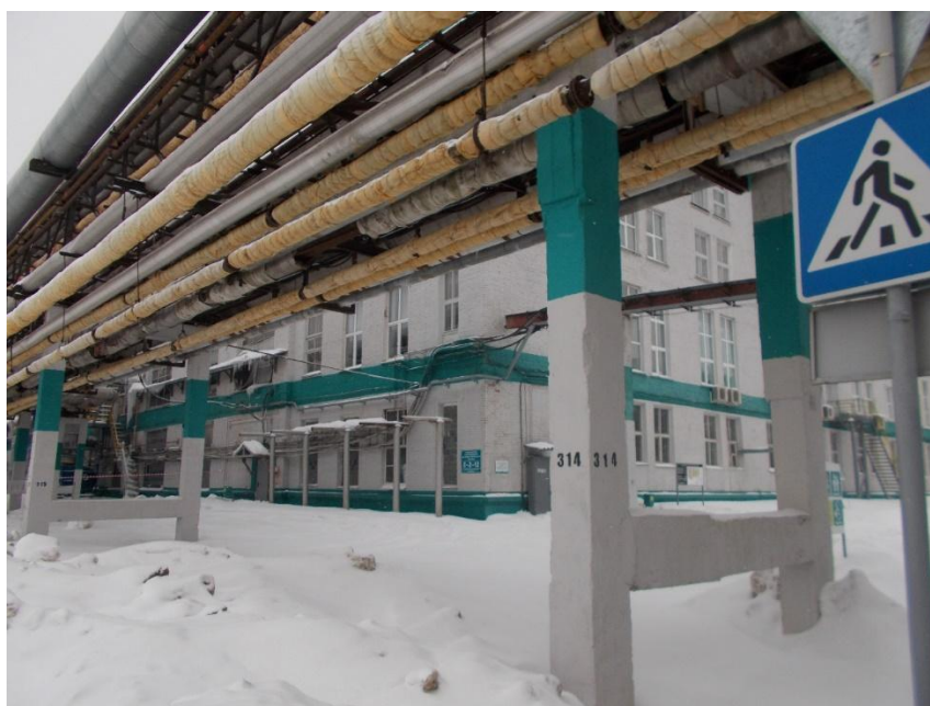
Рисунок 1.1 – Вид здания Е-2 с юго-западной стороны.
