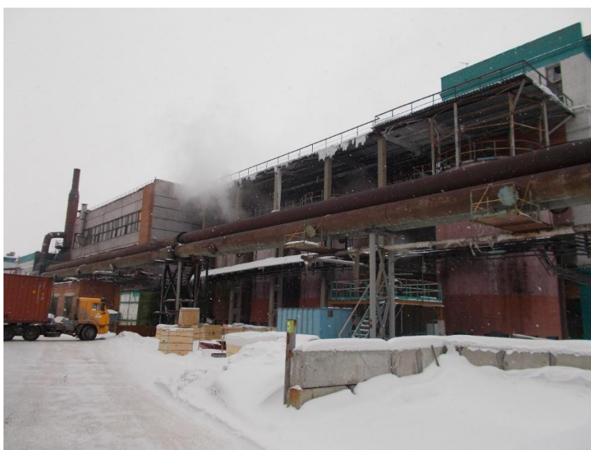
Рисунок 1.2 – Вид здания Е-2 с северной стороны.
