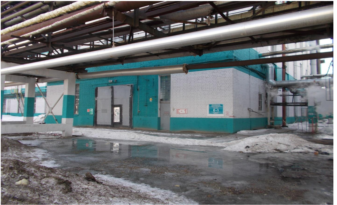
Рисунок 1.3– Вид объекта с западной стороны здания
