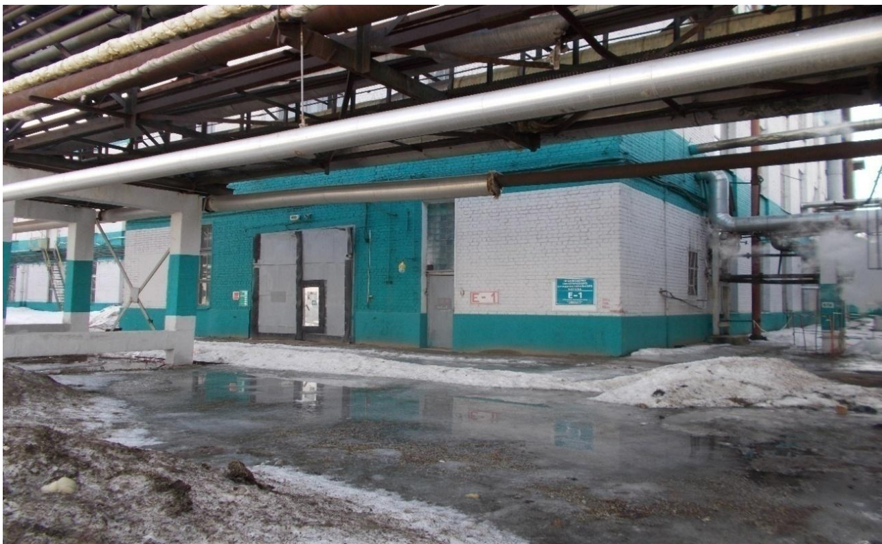
Рисунок 1.2– Вид объекта с южной стороны здания
