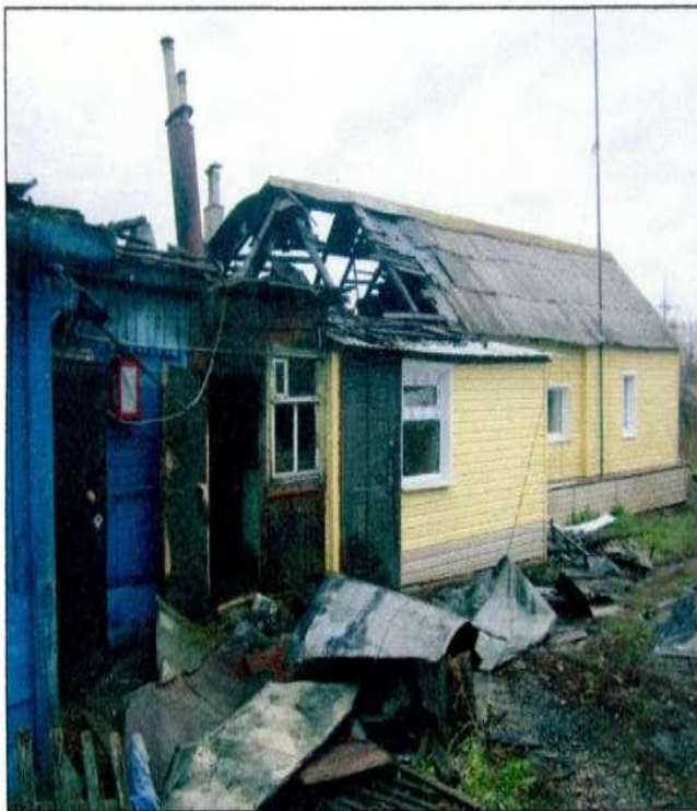
Рисунок 3.1 -Обрушение кровли Рисунок 3.2 -Обрушение кровли
