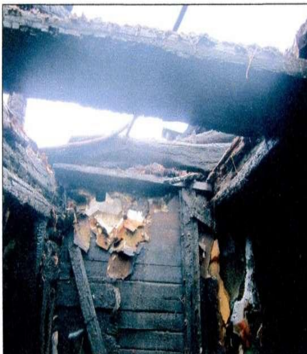
Рисунок 3.3 -Прогар кровли Рисунок 3.4 -Прогар
