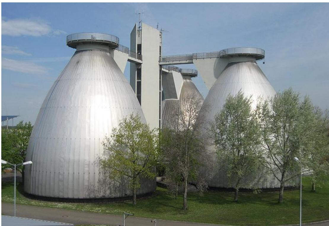
Рисунок 1.3 - Метантенки очистной станции Вайнхайм (Германия)
